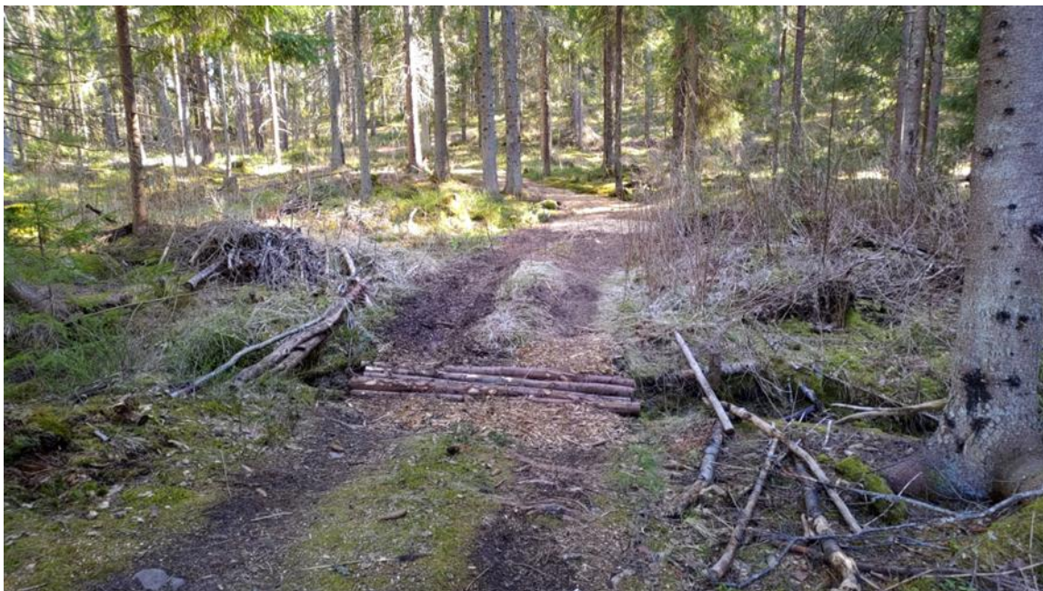
Kuva 25. Silta erään ojan ylityskohdassa.
