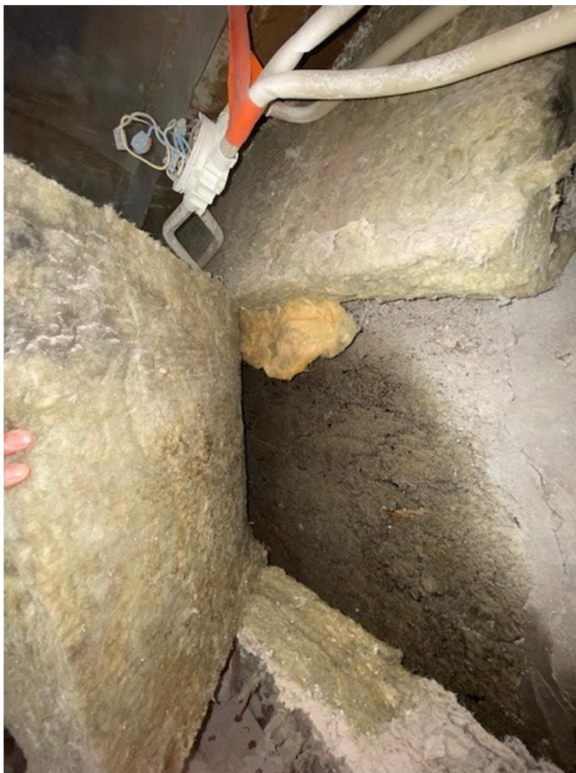
KUVA 3. Villaeristeen ja betoniseinä
