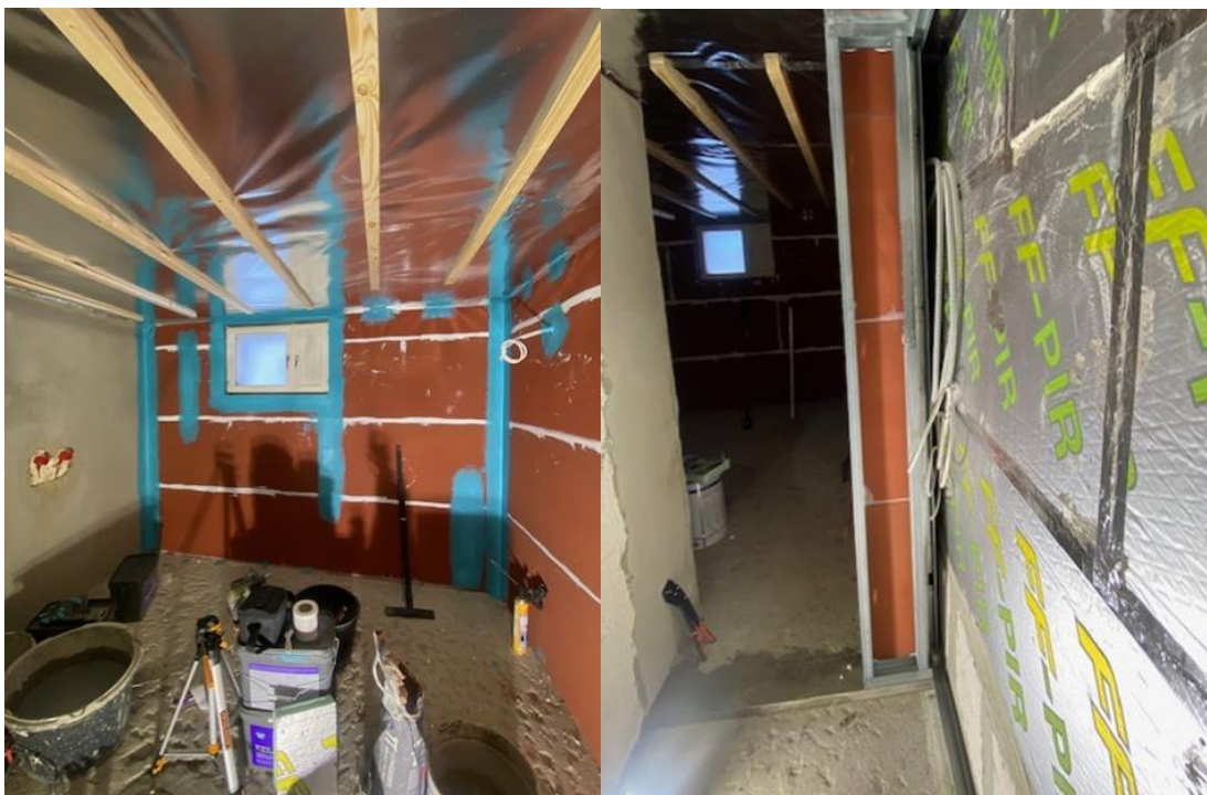
KUVA 14A. Märkätilan levytyksestä KUVA 14B. Märkätilan seinän taakse rako.
