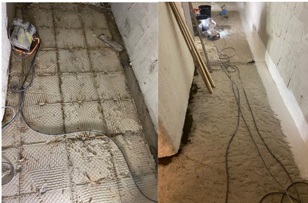
KUVA 6A. Laatoitusta purettu.
