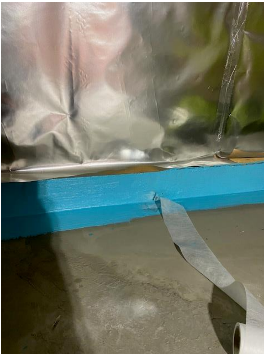
KUVA 19. Saunan nurkkien vedeneristys.
