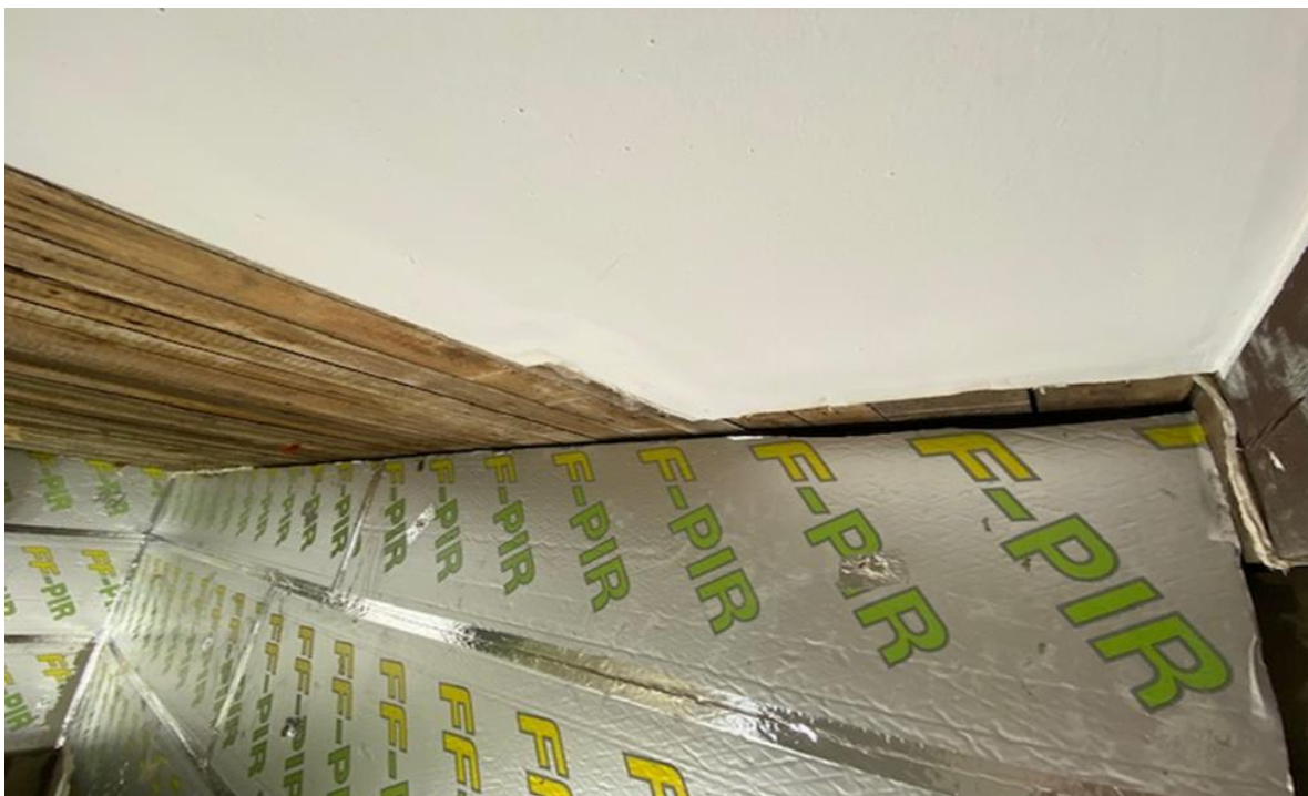
KUVA 10A. Kylpyhuoneen seinä eristettynä.
