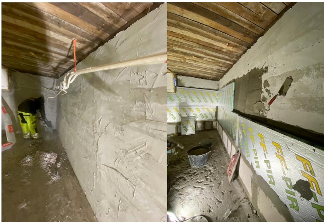
KUVA 9A. Tasoitettu seinä.
