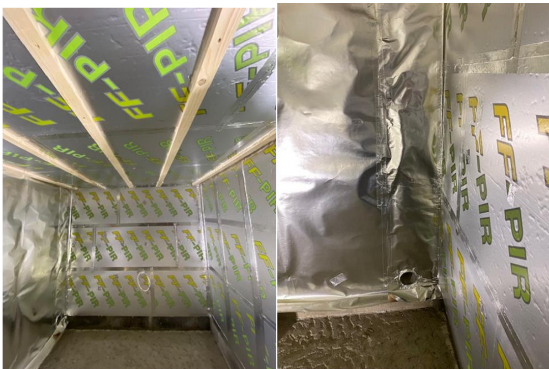
KUVA 11A. Saunan eristys FF-PIR 50. KUVAA11B Saunan ilmanvaihtokanava.
