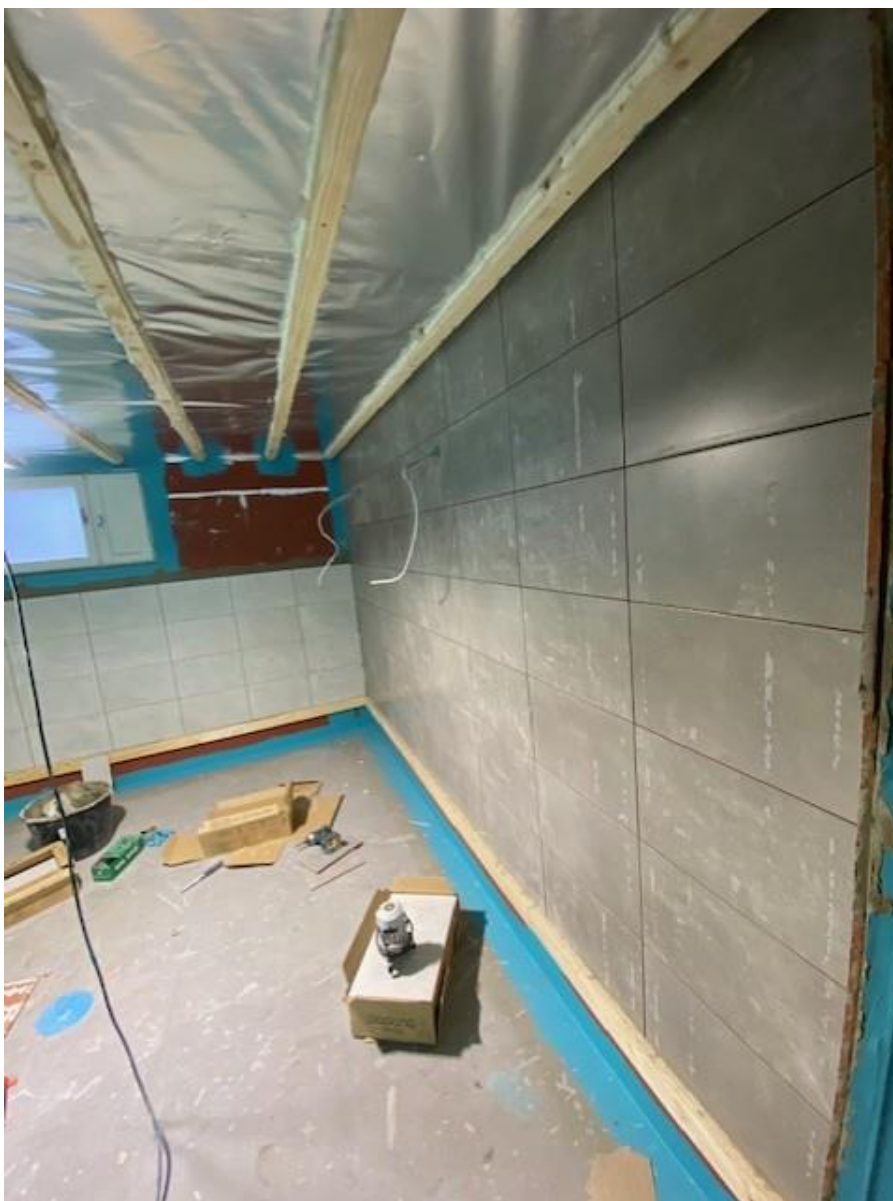
KUVA 21. Seinän laatoitus.
