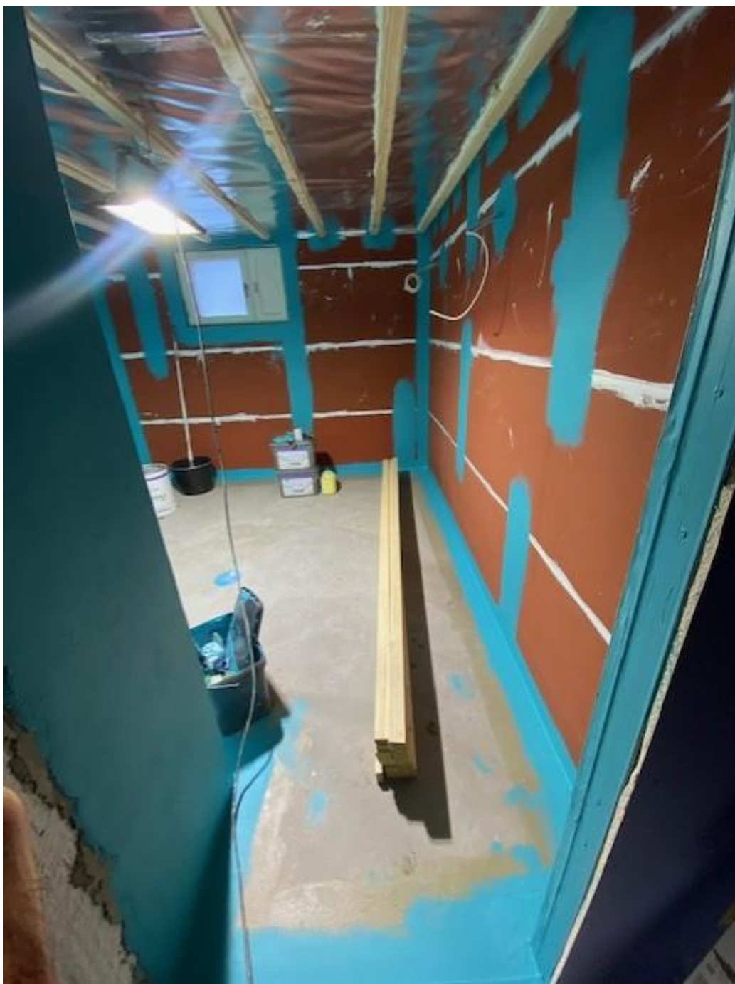
KUVA 20. Märkätilalevy Tulpasta tehdyt seinät vedeneristettynä.
