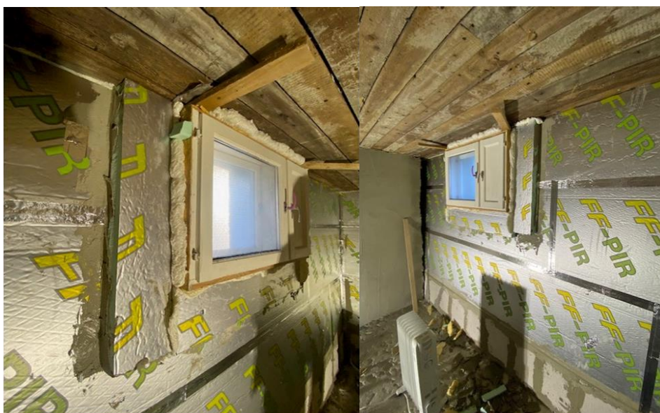
KUVA 10B. Kellarin ikkuna.
