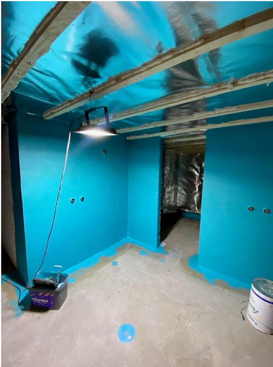
KUVA 18. Kylpyhuoneen vedeneristys.
