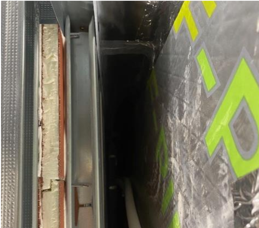
KUVA 15. Lähikuva kuvasta 14B kylpyhuoneen märkätilaseinä.
