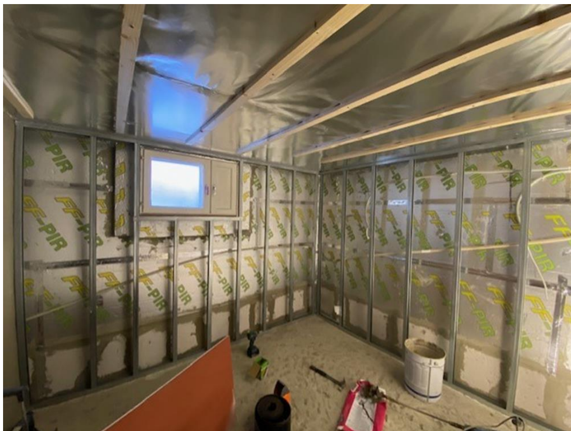
KUVA 12. Seinärakenne tehty Tulppa-märkätilalevyjä varten.
