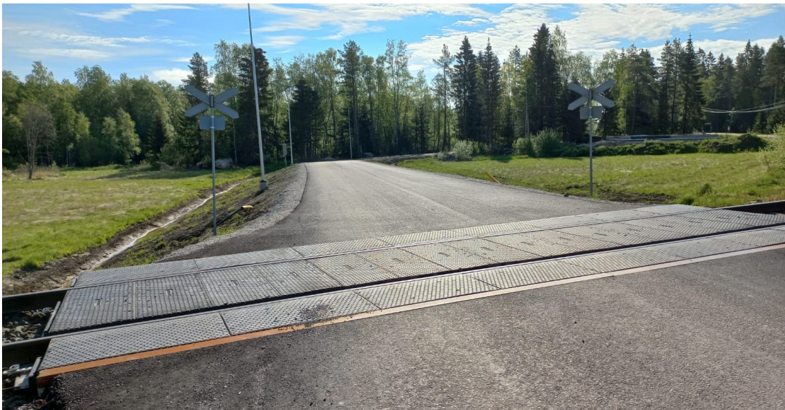
Kuva 8. Kuminen tasoristeyskansi siirtymäpalkeilla.
