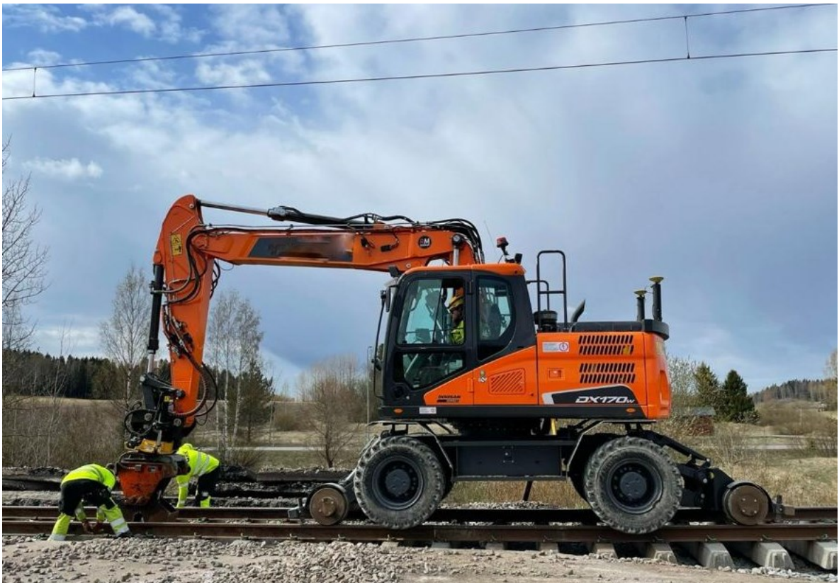
Kuva 14. Kiskopyöräkaivinkone kiskoilla päällysrakenteen vaihdossa. (GRK Suomi Oy, n.d.)
