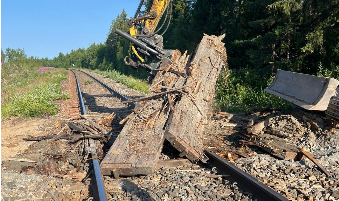
Kuva 18. Puisen tasoristeyskannen purku.
