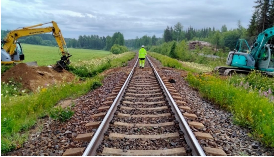
Kuva 16. Tasoristeykskansi poistettu. (Tommi Dahlberg, 2022)
