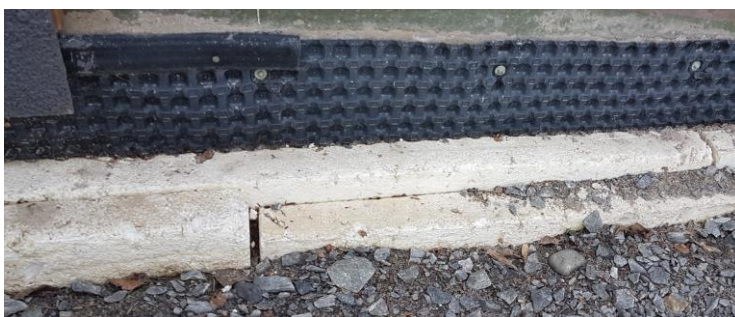
KUVA 5, Sokkelin veden- ja lämmöneristys
