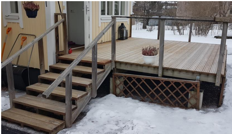
KUVA 34, Sisäänkäynnin rappuset ja terassi
