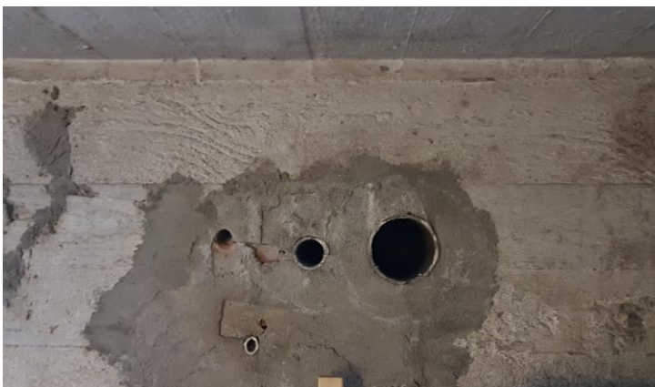
KUVA 10, Läpivientejä kellarin seinässä
