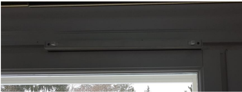
KUVA 42, Korvausilmaventtiili
