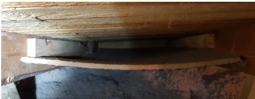
KUVA 16, Tuuletusrako
