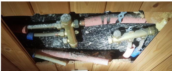
KUVA 8, Pukuhuoneen seinän tarkastusluukku
