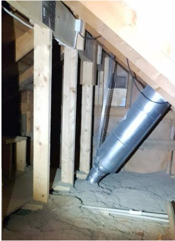
KUVA 17, IV-putki eristämättä
