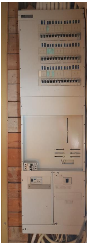
KUVA 37, Sähköpääkeskus
