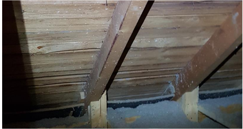
KUVA 15, Aluslaudoitus ja tuuletusrako
