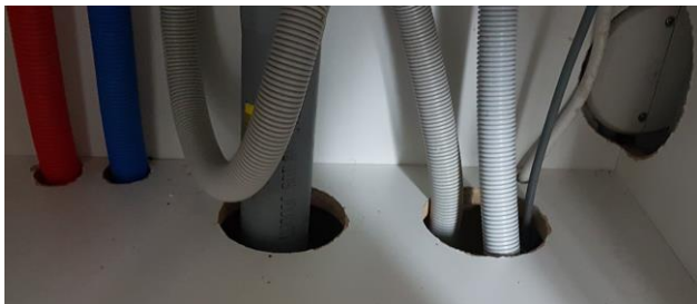
KUVA 32, Allaskaapin läpiviennit
