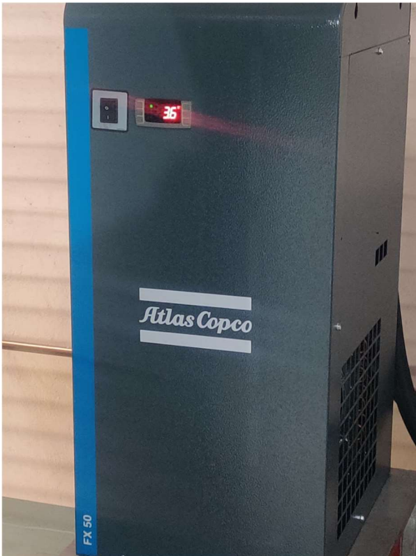
KUVA 14. Suuremman kompressorin jäähdytyskuivain FX50
