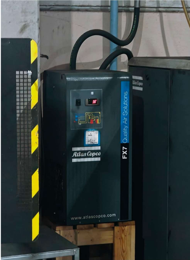
KUVA 13. Pienemmän kompressorin jäähdytyskuivain FX7
