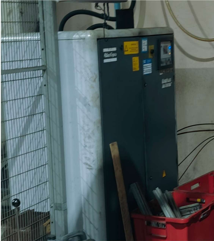
KUVA 9. Nykyisen järjestelmän pienempi kompressori GA 15 FF
