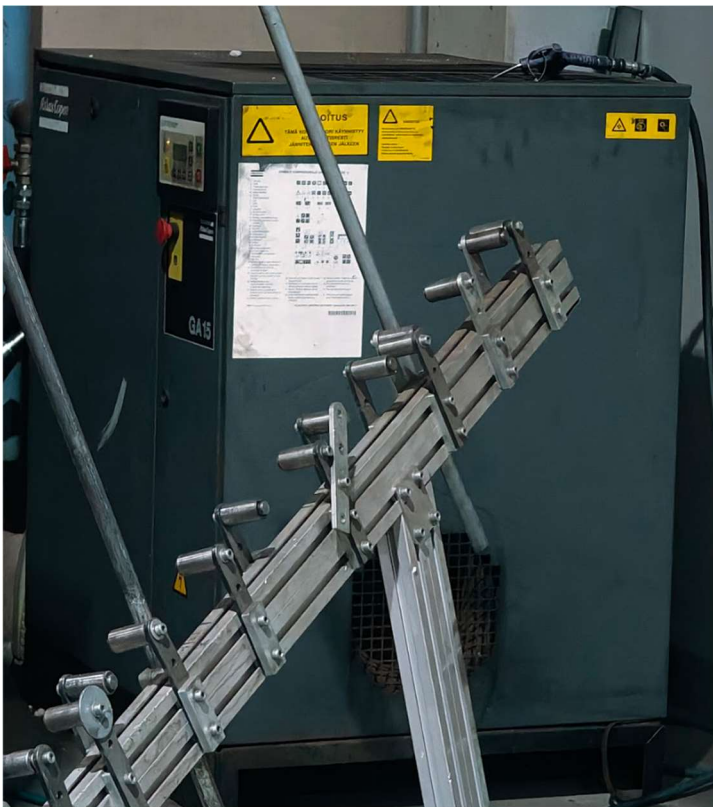
KUVA 10. Nykyisen järjestelmän suurempi kompressori GA 15
