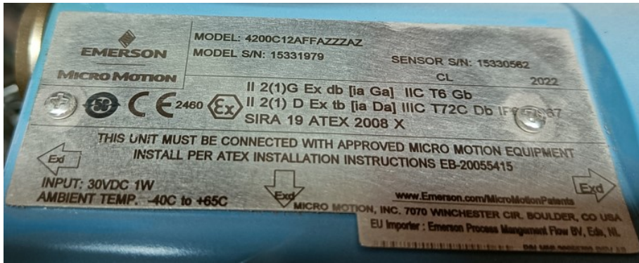
KUVA 6. Micro Motion 4200-lähtetimen tyyppikilpi
