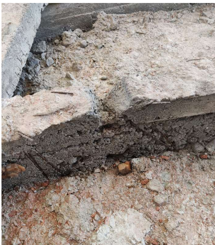
KUVA 30. Olemassa olevat betonirakenteiset laippapalkit. (Dracon Oy 2023j)
