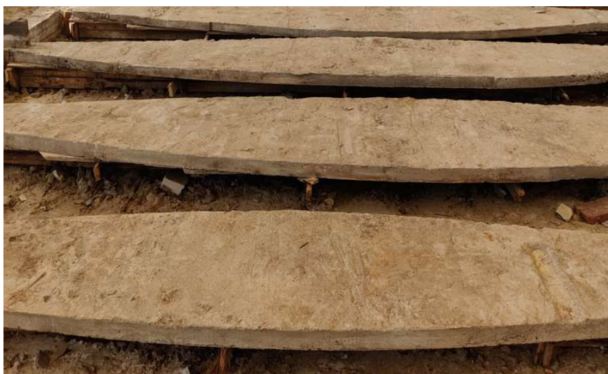
KUVA 29. Työmaalta otettu kuva jo olemassa olevista laippapalkkirakenteista. (Dracon Oy 2023i)
