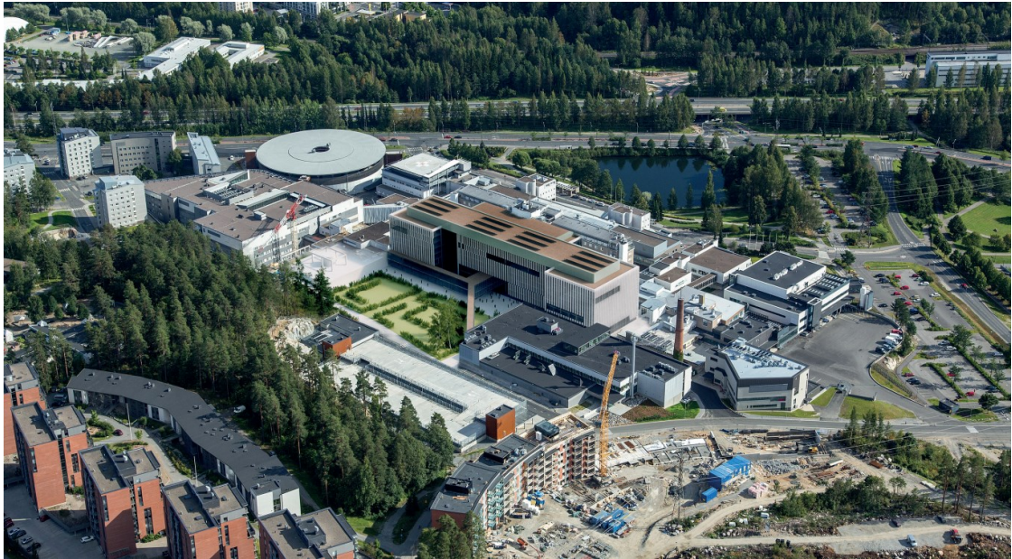
Kuva 1. KYS uudistuu. Ilmakuva luoteesta (Arkkitehdit Kontukoski 2016).
