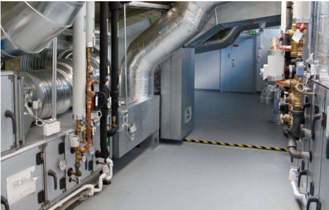
Kuva 3. Polyuretaanipinnoite IV-konehuoneessa (Tikkurila, i.a.-c).
