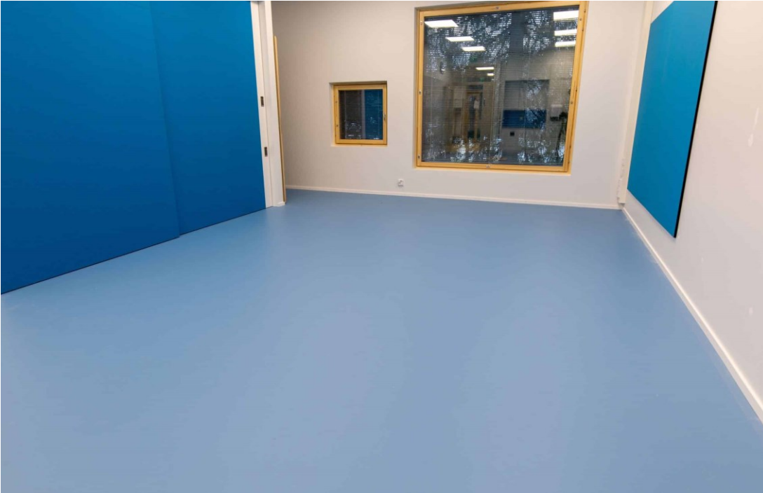
Kuva 4. Polyuretaanipinnoite päiväkodissa (Byggma, i.a.).
