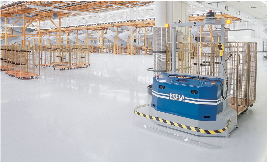
Kuva 1. Epoksilattia teollisuustilassa (Erikoislattiat, i.a.).
