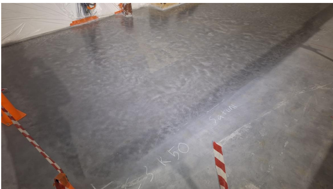
KUVA 10. Toisessa mallihionnassa lattia hiottiin C-luokkaan ja kiillotettiin luokkaan 3 eli satiiniksi sekä suoja-aineeksi valittiin R50 (Nikula 2024).
