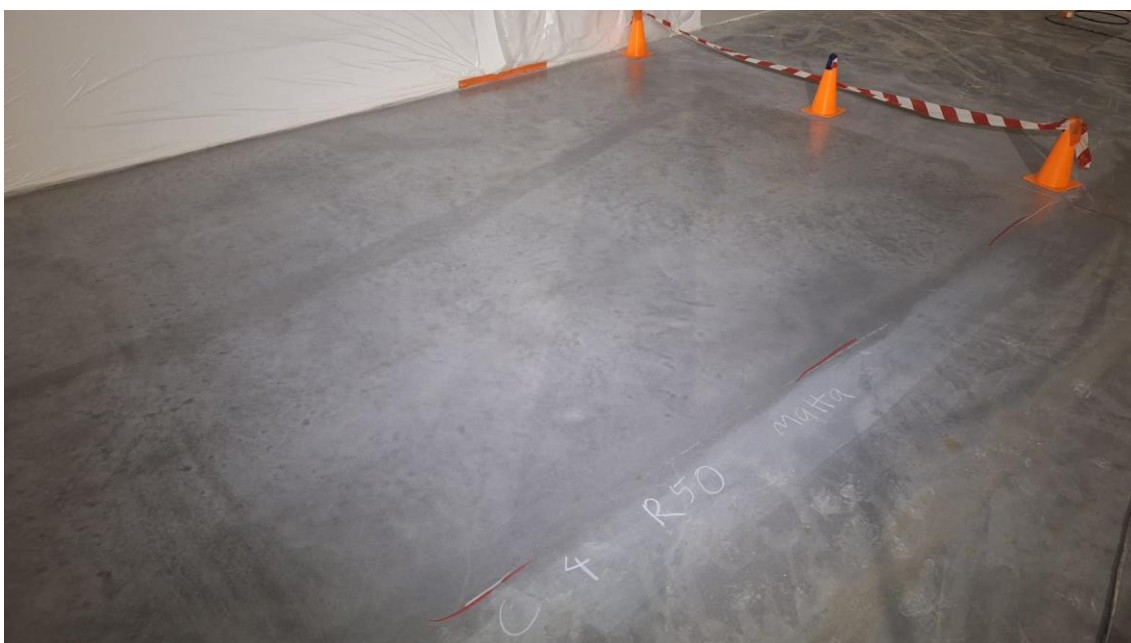
KUVA 12. Neljännessä mallihionnassa lattia hiottiin C-luokkaan ja kiillotettiin luokkaan 4 eli matakksi sekä suoja-aineeksi valittiin R50 (Nikula 2024).
