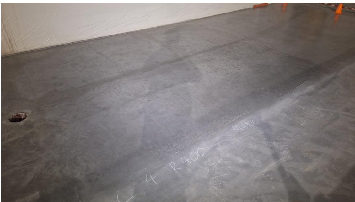
KUVA 11. Kolmannessa mallihionnassa lattia hiottiin C-luokkaan ja kiillotettiin luokkaan 4 eli matakksi sekä suoja-aineeksi valittiin R400 (Nikula 2024).
