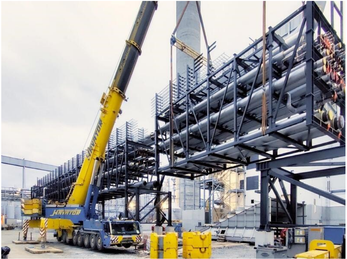
Kuvio 1. Putkisillan asennus (Paasikangas 2023)
