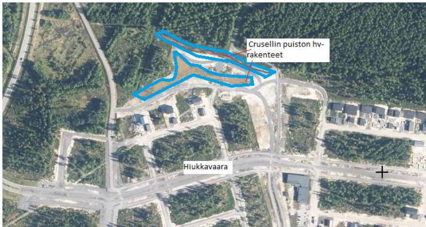
KUVA 15. Hulevesirakenne Hiukkavaarassa, joka on rajattu sovitusti sinisellä
