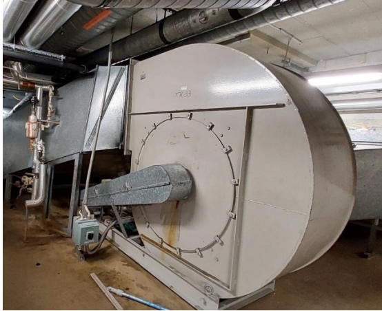
Kuva 5. TK33 hihnavetoinen radiaalipuhallin
