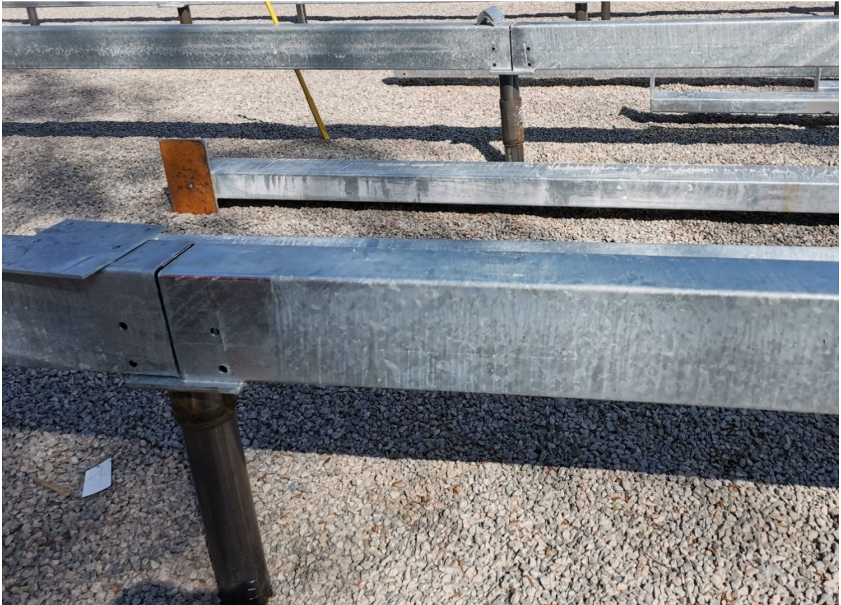
Kuva 6. Teräspalkkien pulttiliitos, Lastentalo Kaarina.
