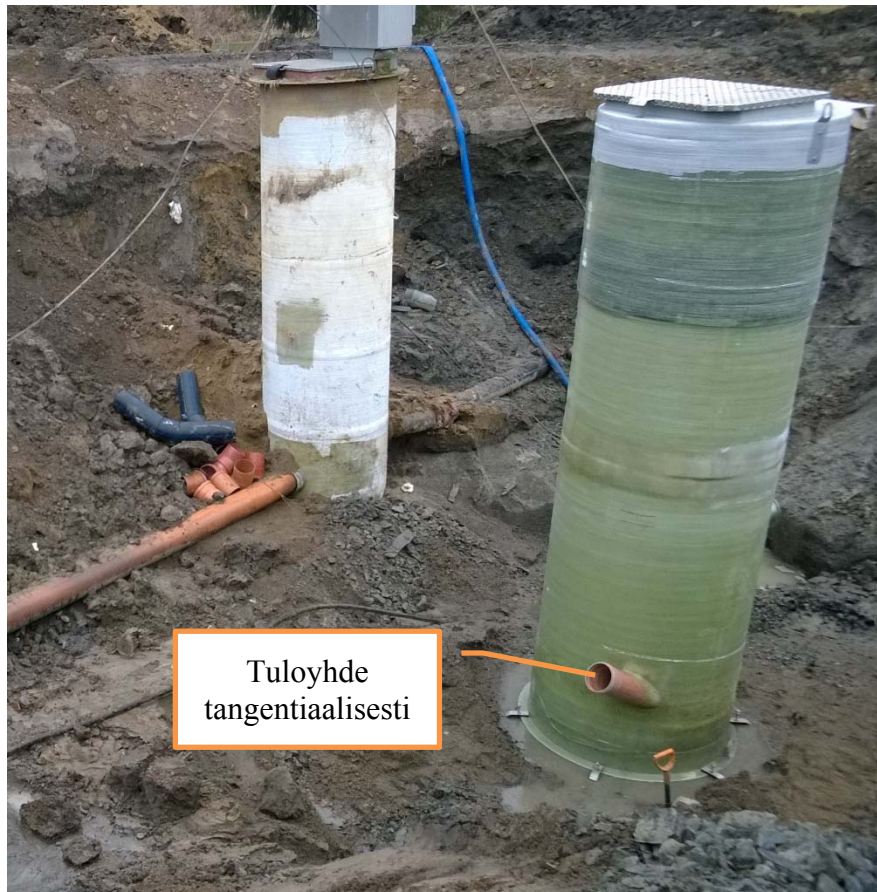
Kuva 22. Uusi pumppaamokaivon vanhan kaivon viereen, Toijala, Kilsa-jätevedenpumppaamo
