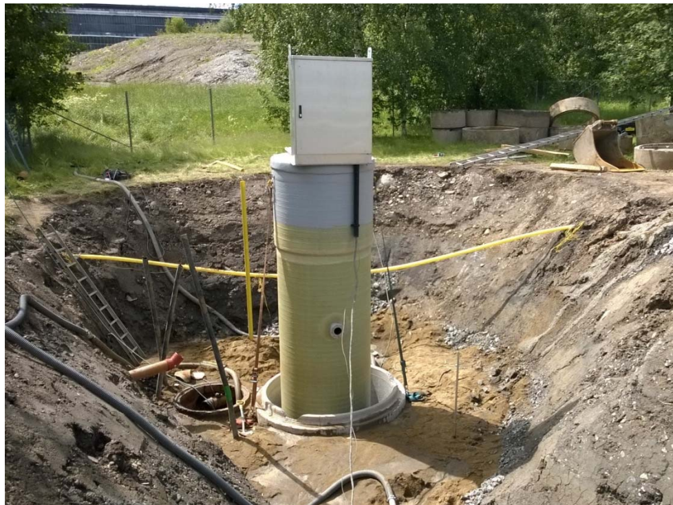
Kuva 24. I-Valon jätevedenpumppaamon saneeraus, kesäkuu 2014
