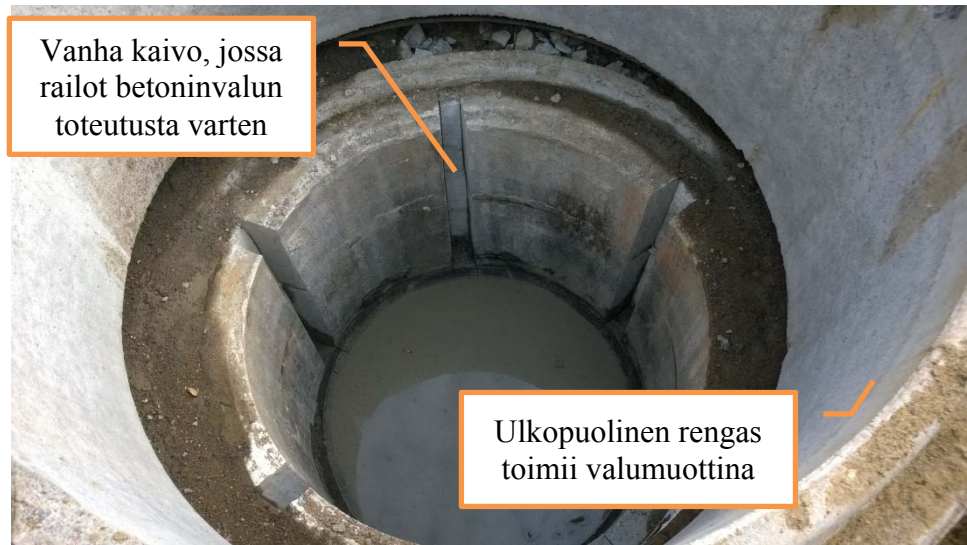
Kuva 23. Vanhan betonirengaskaivon perustuksen hyödyntäminen
