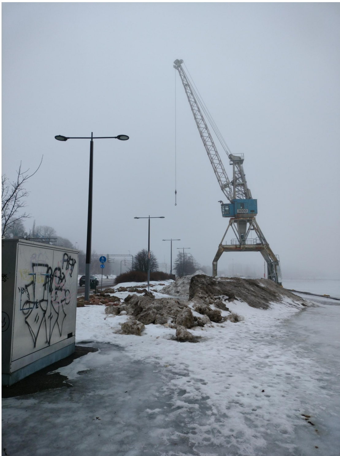
Kuva 36. Kuvassa useampi SignifyOSB-katulamppu
