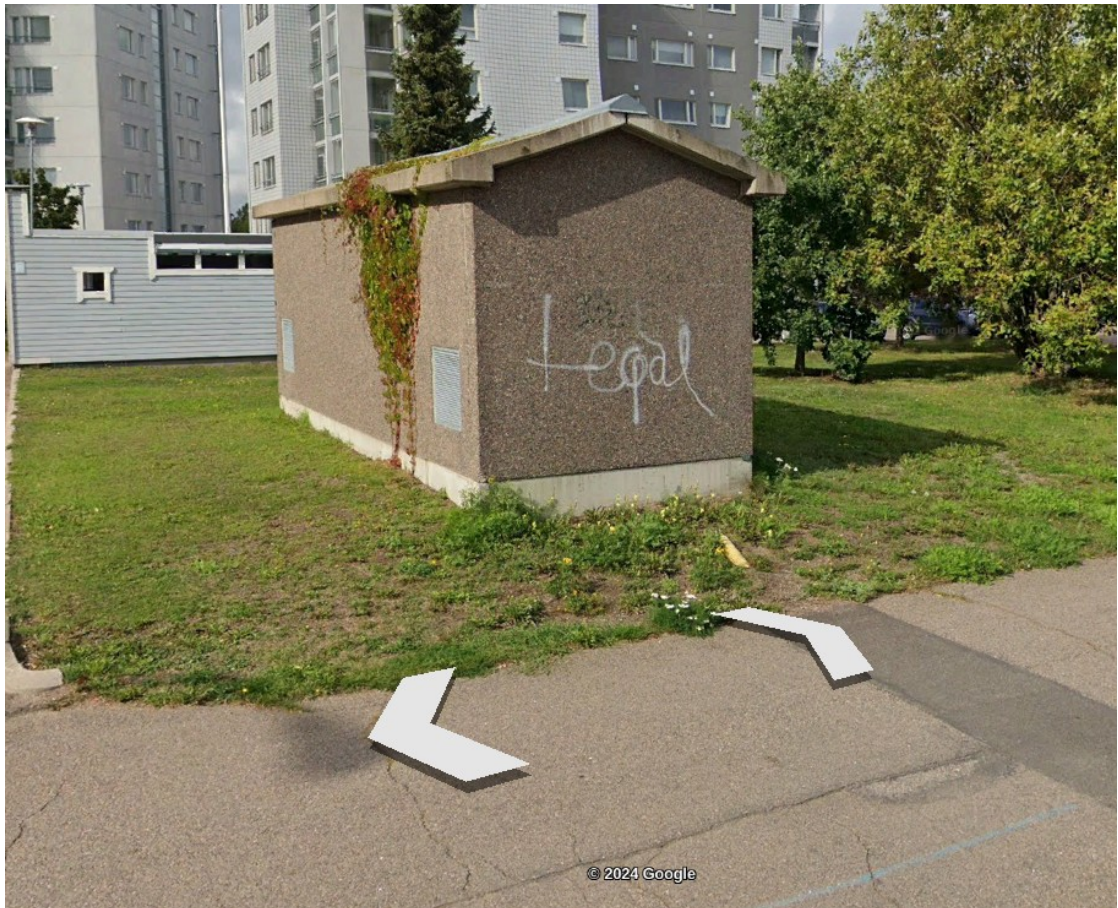
Kuva 41. Google Earthin katunäkymästä otettu kuvakaappaus, jossa näkyy luultavasti vesipumppaamo (Google 2022)
