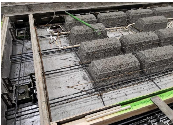
Kuva 5. Superlaatan varustelu ja esijännitys.
