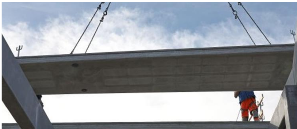
Kuva 2. Luja-Superlaatan alapinta (Lujabetoni Oy 2018a).
