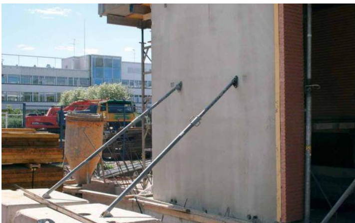
Kuva 15. Elementin asennustuenta (Ramirent Oyj 2024).
