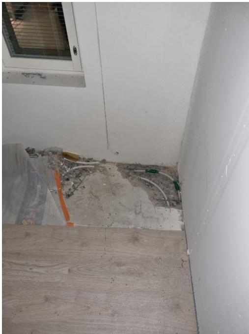
Kuva 17. Korjattu lattialämmitysputki.
