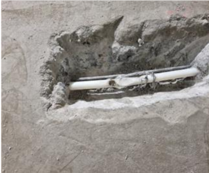
Kuva 14. Vahingoittunut lattialämmityspotki.
