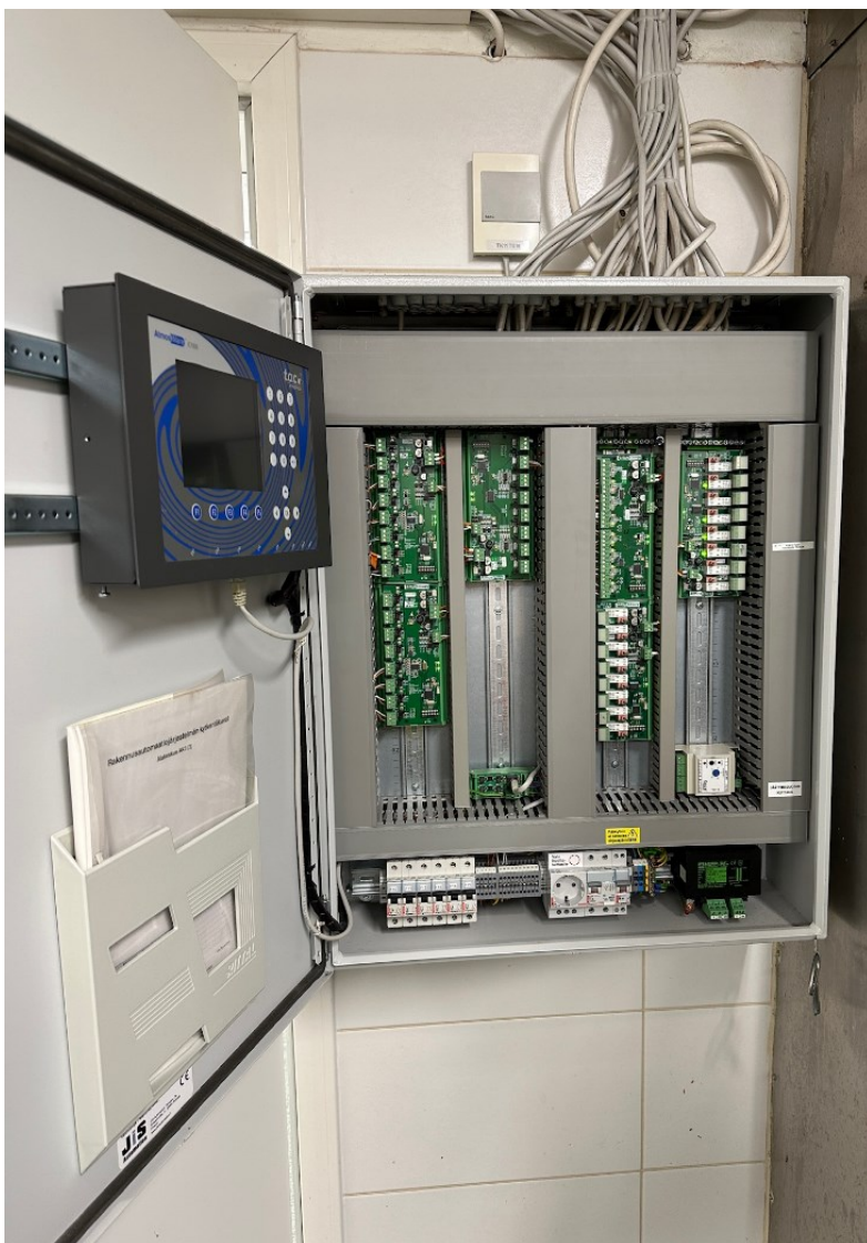
KUVA 14. Vanha AK03 valvonta-alakeskus
