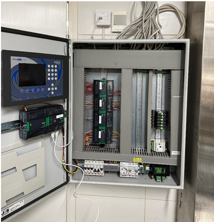
KUVA 46. Testausta vaille valmis alakeskus
