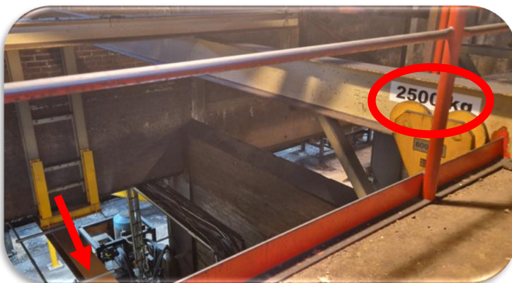
Kuva 9. Poistettava nostinkisko (Kuva: Jyri Reijonen).
