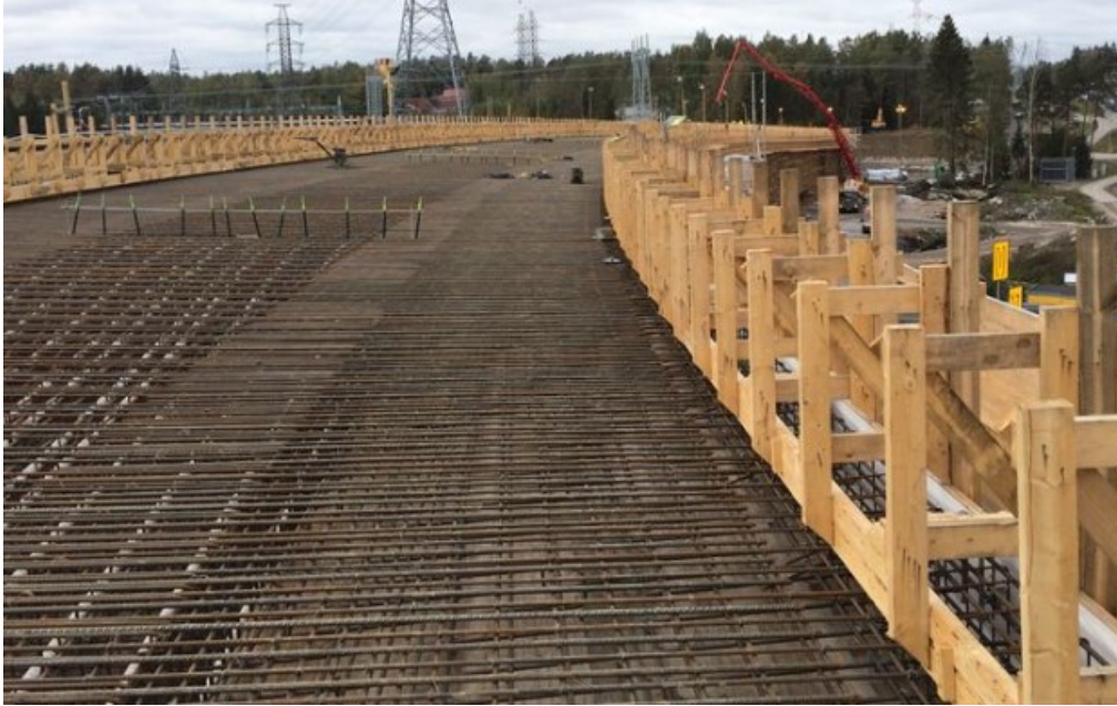
Kuvio 4. YIT:n toteuttama täysin tietomallinnettu silta
