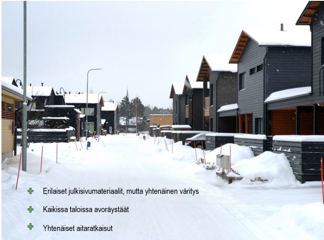
KUVA 9. Puu-, tiili- ja rapatut julkisivut vierekkäin 10.12.2023, muokattu 23.2.2024.
