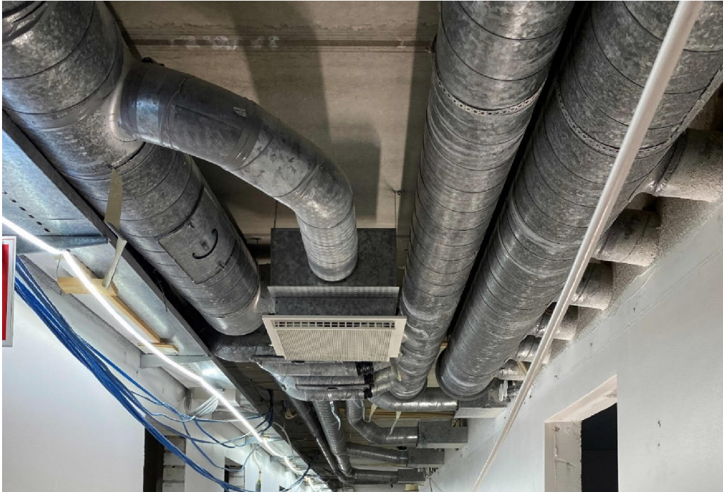
Kuva 8. Saneerauskohteen peruskorjaus, tele ja ilmastointi uudistetaan kokonaan.
