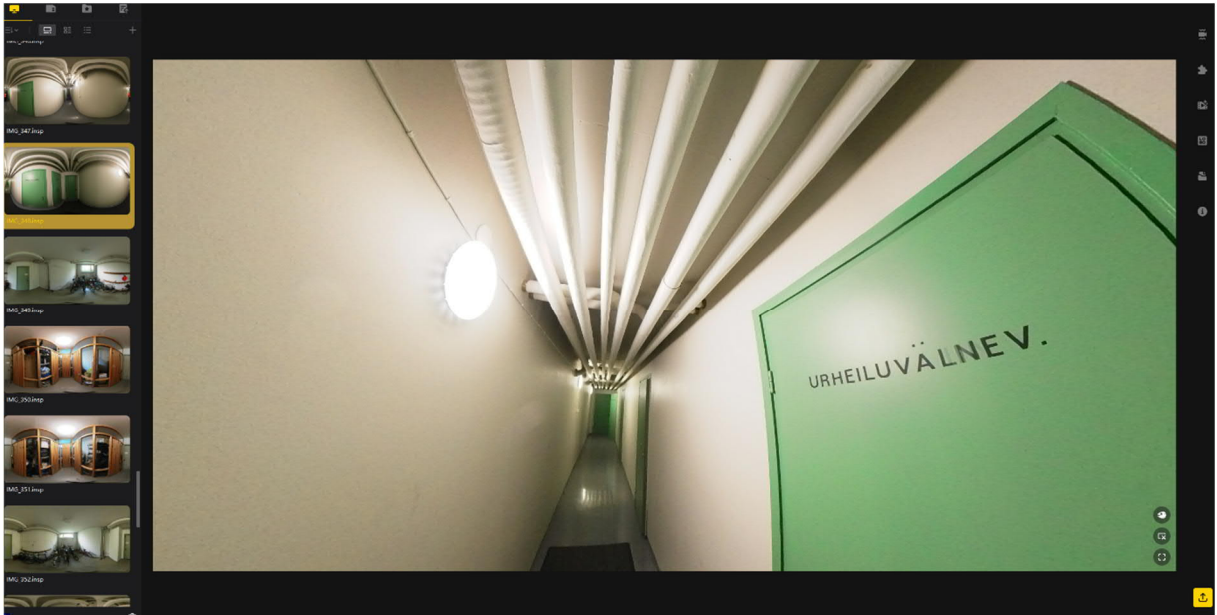
Kuva 11. Taloyhtiön porrashuoneiden välinen käytävä
