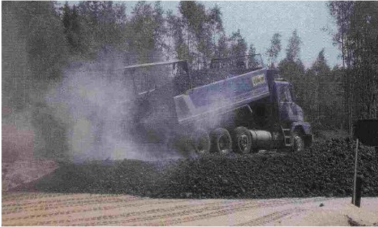
KUVA 9. LD-teräskuonan levitys tielle (Tielaitos 1996)
