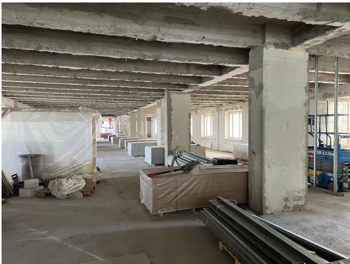
Kuva 12. Väliseinätarvikkeet ja henkilönostimet haalattu toiseen kerrokseen. Kuvassa näkyy myös putsareiden laastinsekoituspiste pölyosastoituna. (Joonas Mara, 2022)
