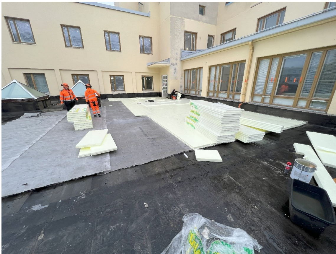
Kuva 11. Pihakannen ensimmäisen valulohkon vedeneristys-, salaojitus- ja lämmöneristekerrokset asettumassa paikoilleen. (Mara 2022)
