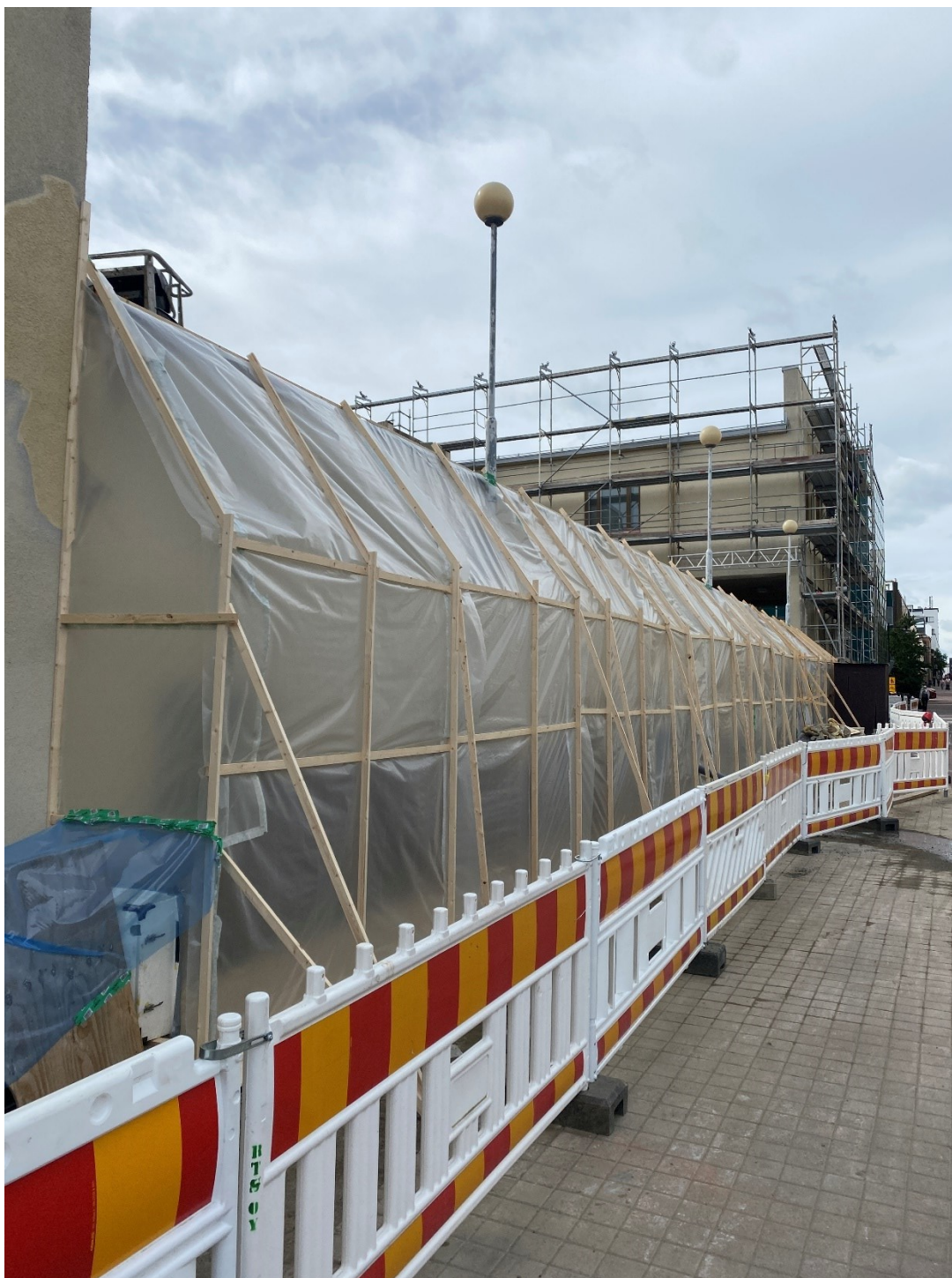
Kuva 6. Kirjastokadun alipaineistettu sulkutila ulkoseinärappauksen poistoa varten (Jääskeläinen, 2022)
