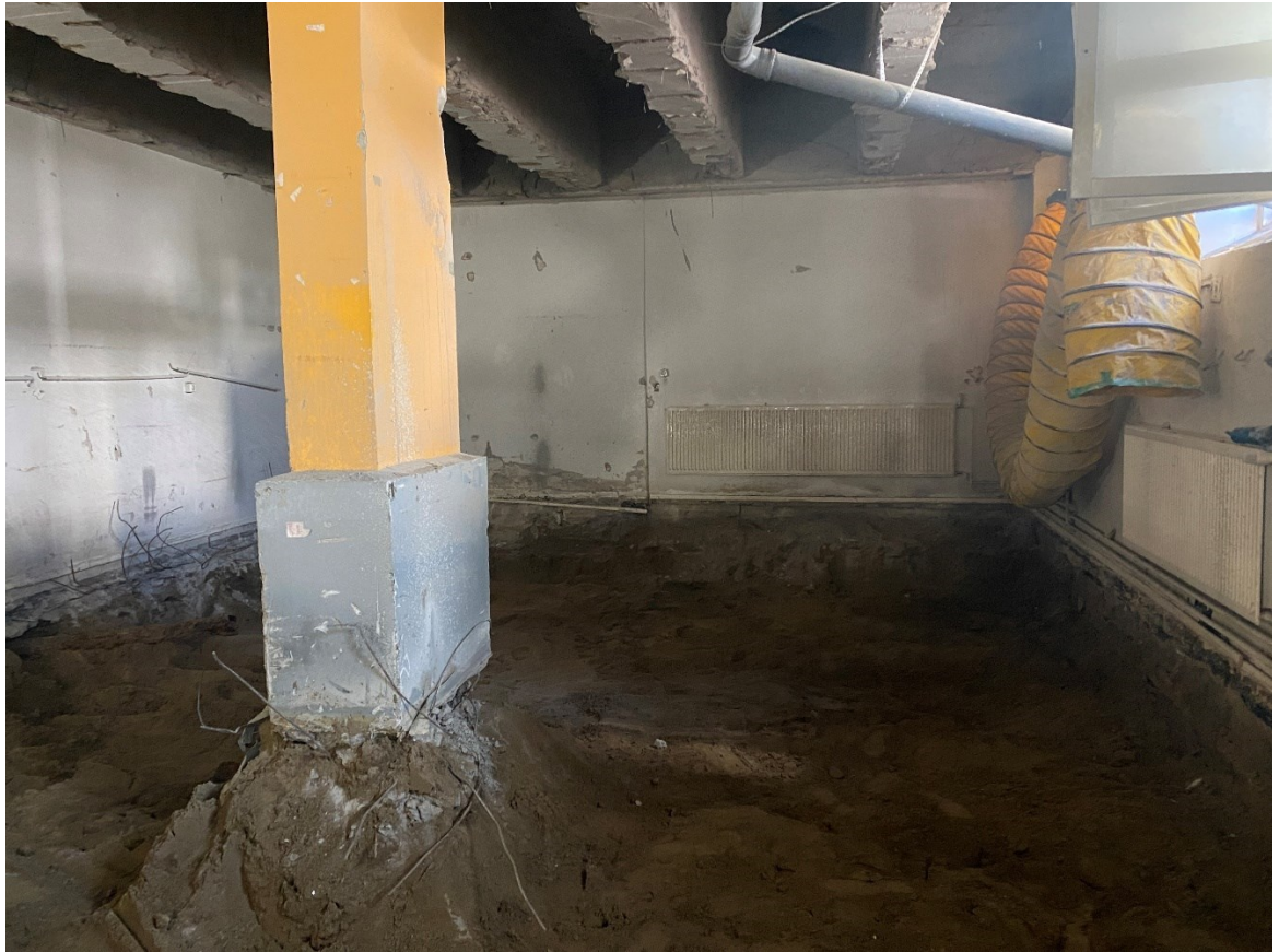
Kuva 7. Kellarikerroksen perusmaata poistettu kapillaarikatkokerroksen tieltä (Jääskeläinen 2022)
