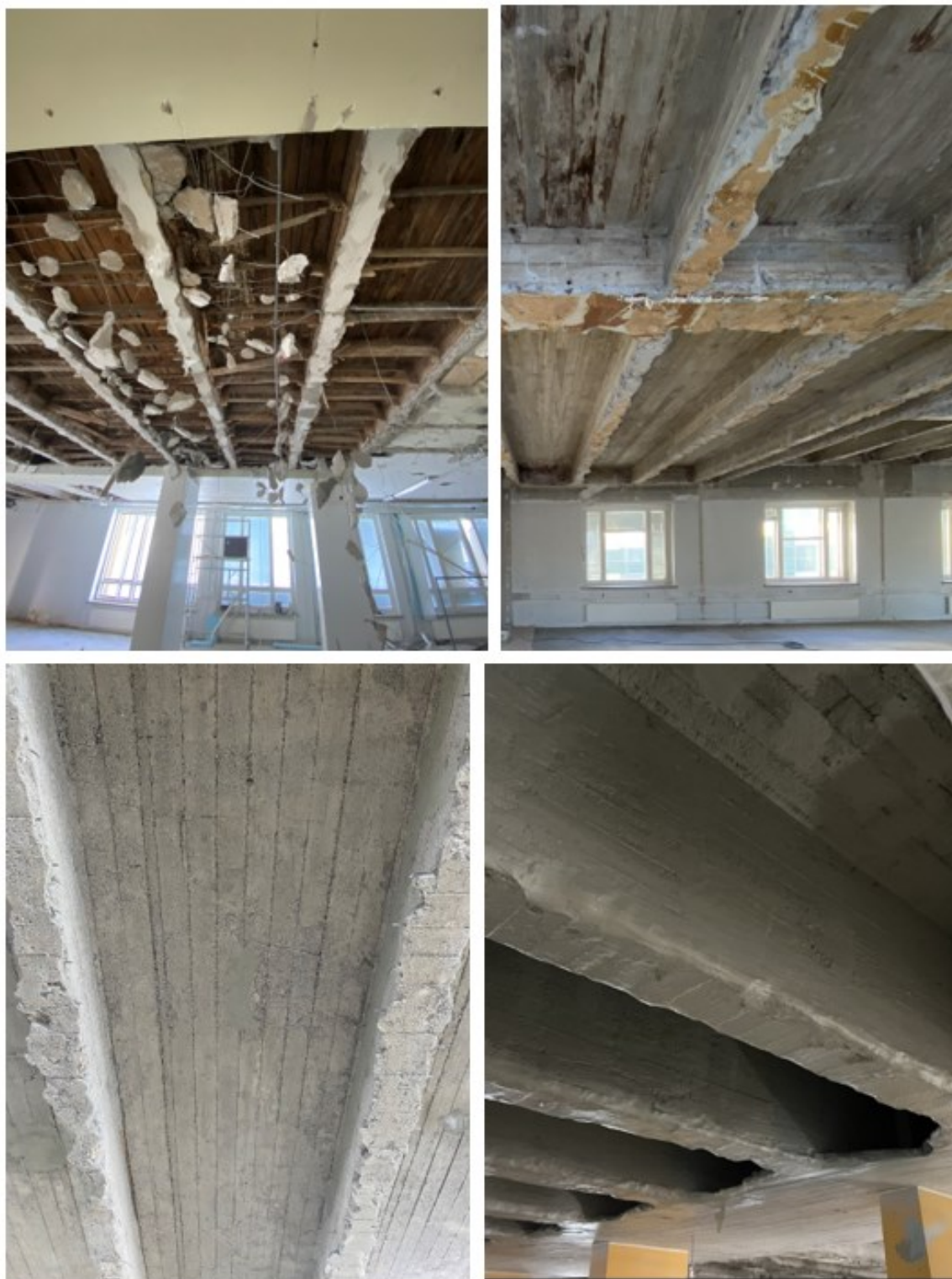
Kuva 10. Alalaattapalkiston korjauksen vaiheet: Laatta purettu, muotit purettu, pinnat hiekkapuhallettu, pinnat paikattu ja pölynsidontamaalattu. (Jääskeläinen 2022)
