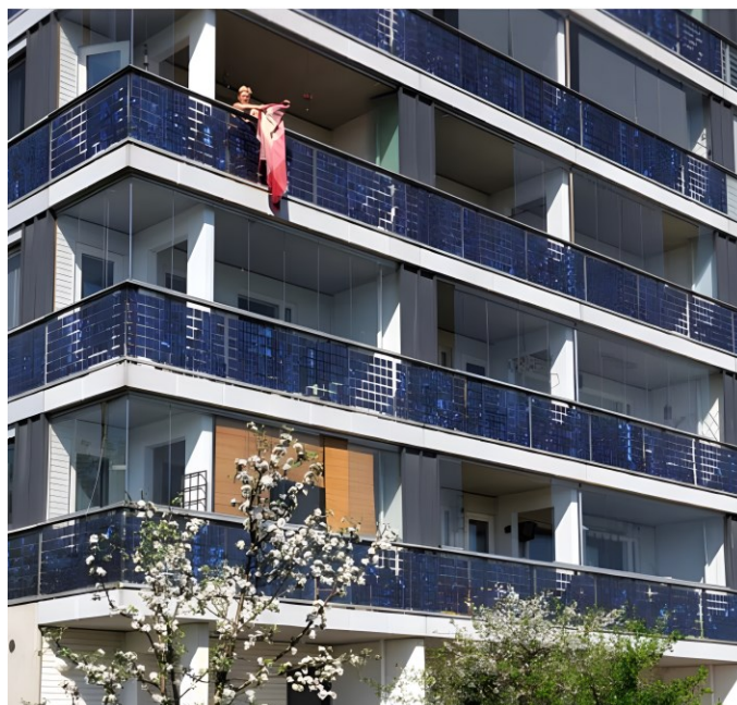
Kuva 13 As Oy Helsingin Salvia parvekejulkisivu, jossa kaiteissa aurinkopaneelleja (RT 103076 Verkkoon kytketyt aurinkosähköjärjestelmät 2019)
