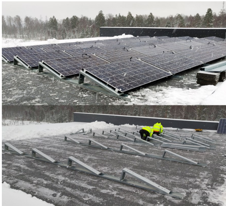
Kuva 5 Painotettava tasakattoratkaisu ALFA, tasakatolle tarkoitettu telineratkaisu (Orima-Tuote Oy, n.d)
