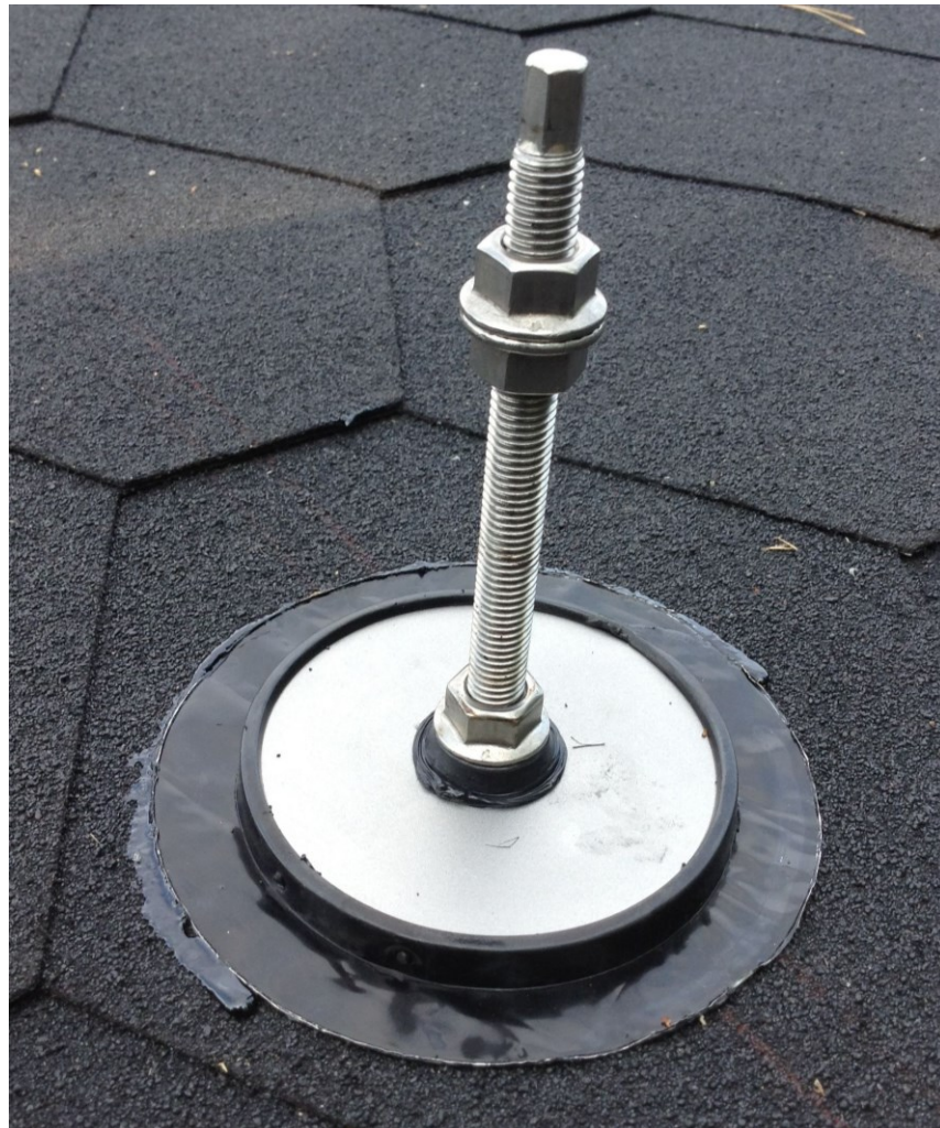
Kuva 6 Aurinkopaneelien kehikon kiinnityspisteenä toimiva ankkuripultti tiivisteinen jyrkällä kermikatolla (Aurinkovirta.fi 2023)
