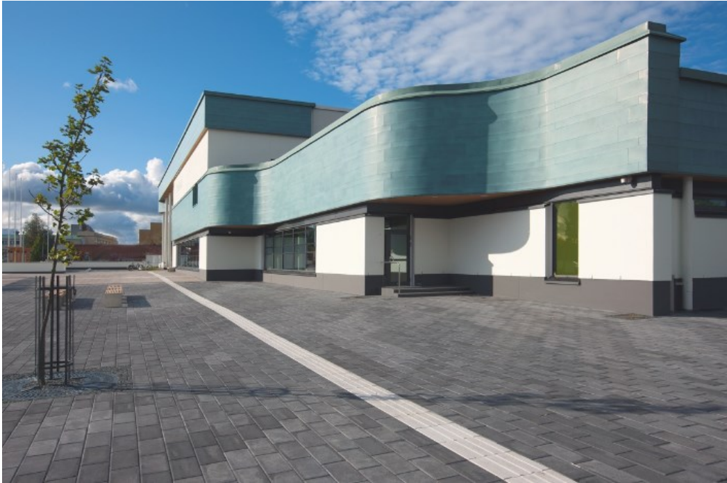
Kuva 11 Porin keskustan uimahalli, kuparikatteen alla aurinkolämpökeräimiä (Projektiutiset.fi 2015)
