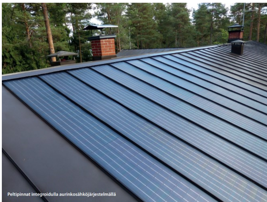
Kuva 1 Virte Aurinkokatto- järjestelmä, jossa saumattuun peltikattoon integroitu ohutkalvopaneeli (RT 38743, Virte Aurinkokatto™ Virte Aurinkoseinä™ Virte Solar Oy)
