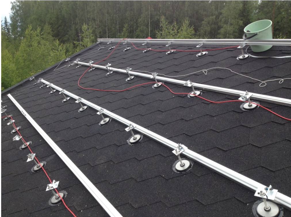
Kuva 7 Jyrkkä palahuopakatto valmisteltuna ankkuripulteilla ja profiilikiskoilla paneeliasennuksia varten (Aurinkovirta.fi 2023)
