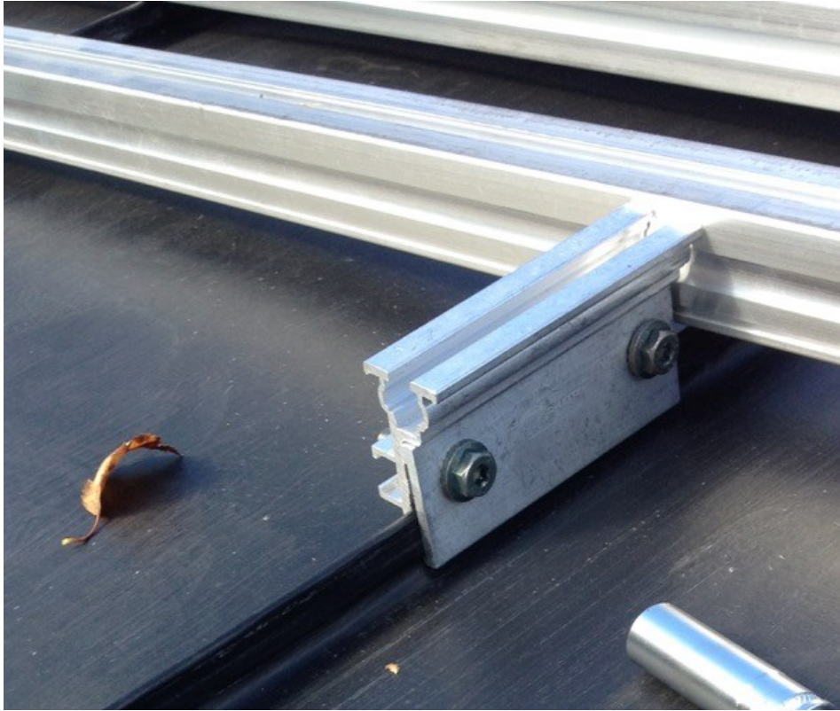
Kuva 8 Saumatun peltikaton puristuskiinnike (Aurinkovirta.fi 2024)
