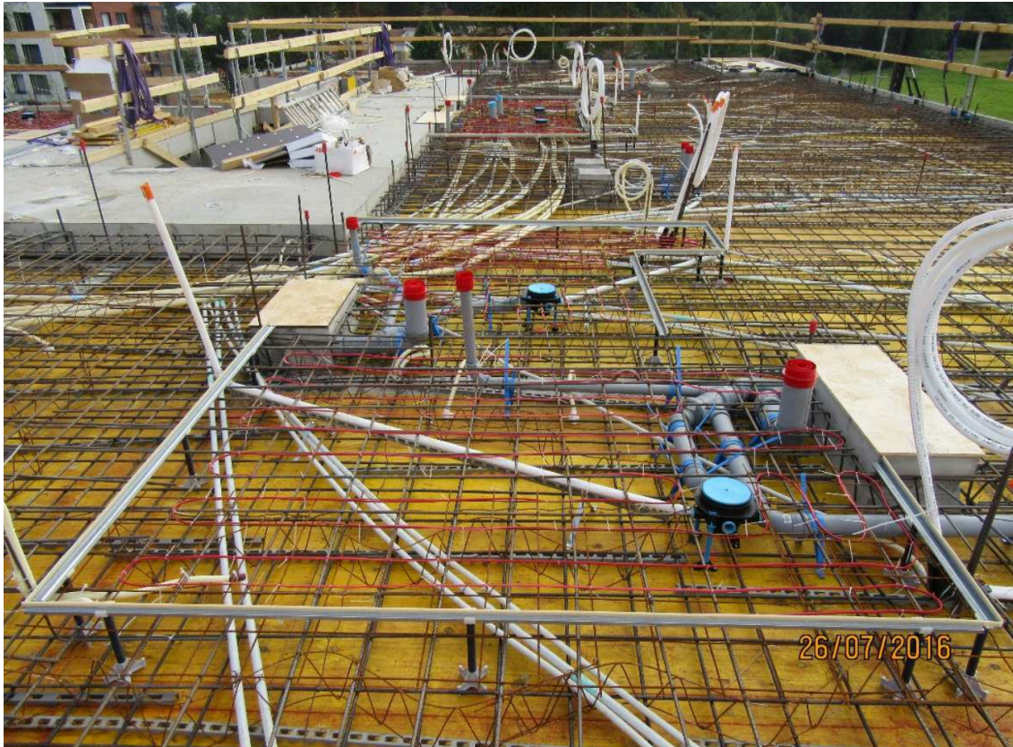
Kuva 16. Paikallavaletun kerrostalokohteen välipohjan raudoitus. (Mustafa, 2017)
