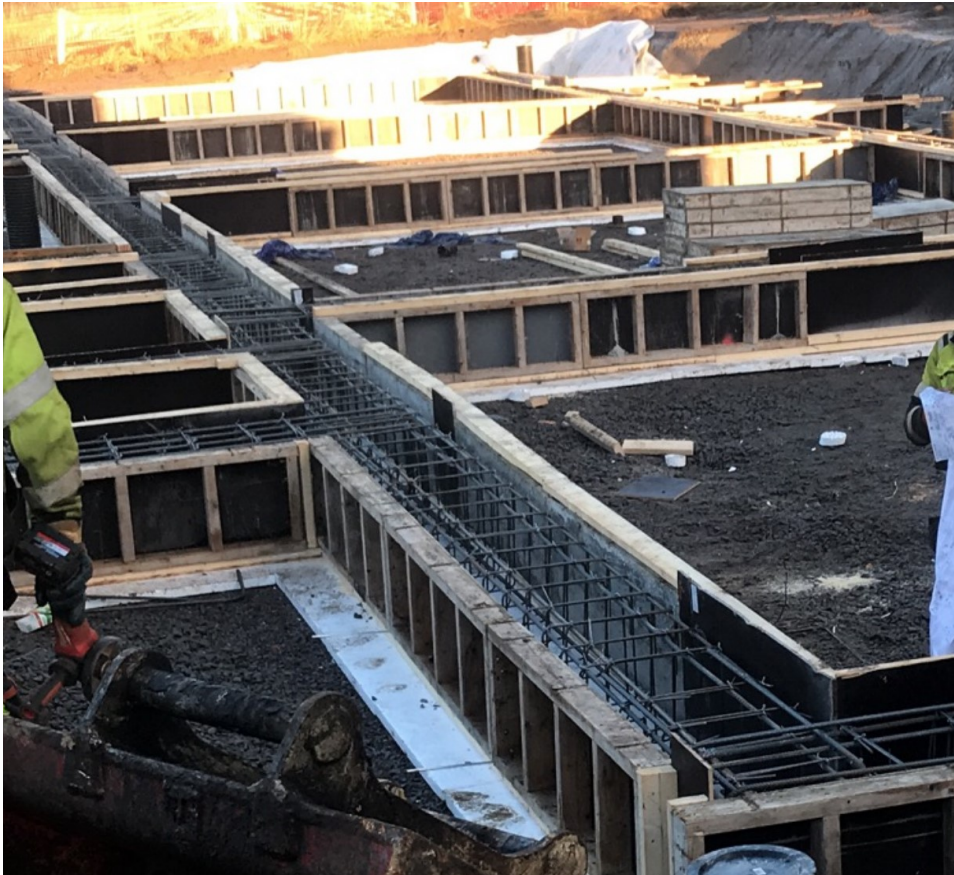
Kuva 15. Tyypillisten nauha-anturoiden rauditus kerrostalokohteessa.
