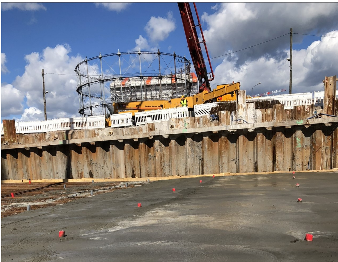
Kuva 13. Paalulaatan valamista Helsingin Sompasaaressa.
