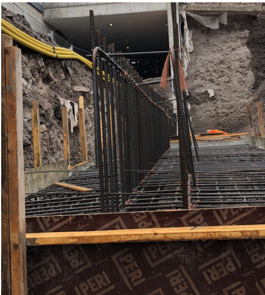
Kuva 10. Valmis sillan anturaraudoitus tartuntoineen.
