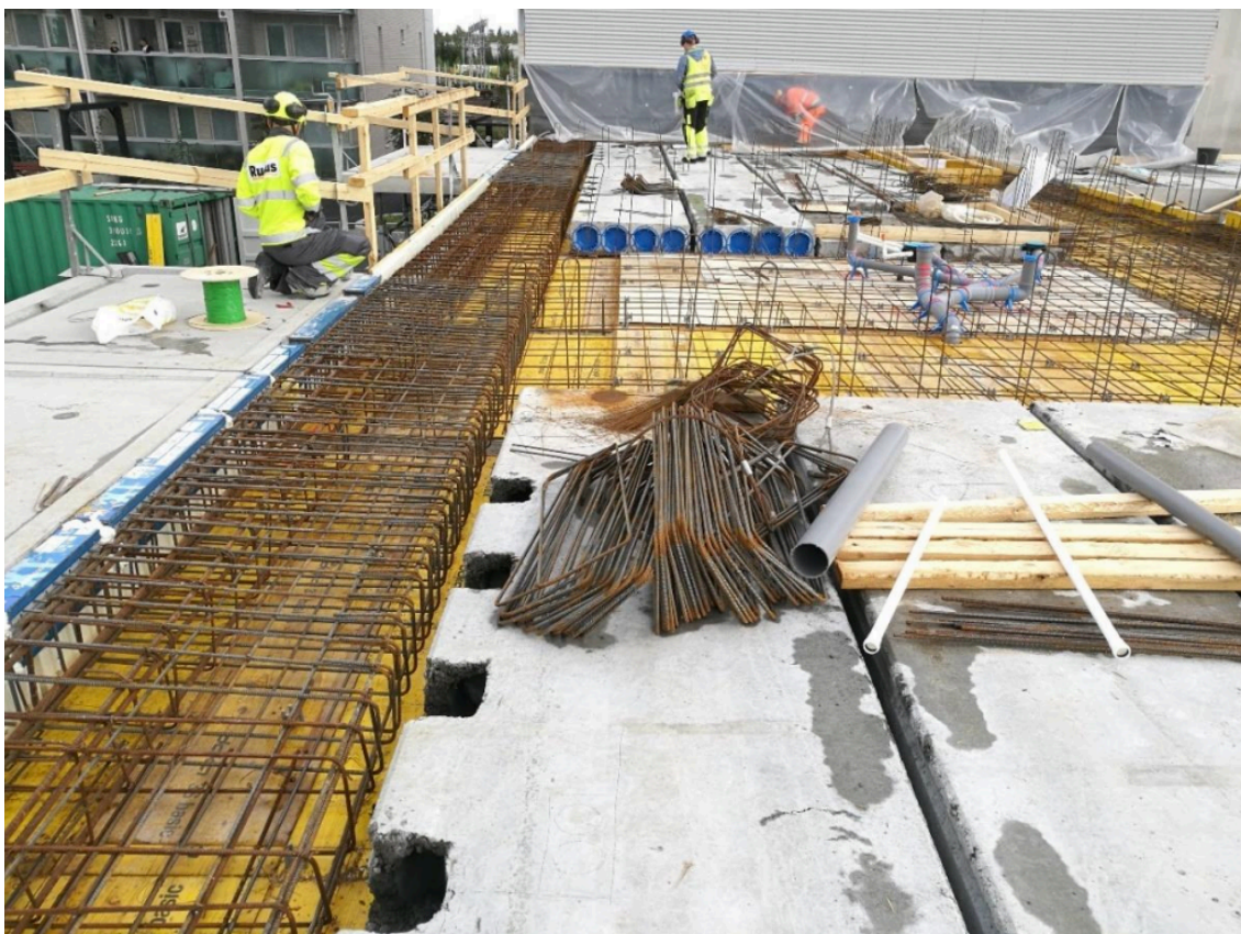
Kuva 32. Valmis Schöck-parvekkeen paikallavalukaistan raudoitus. (Niskanen, 2019)
