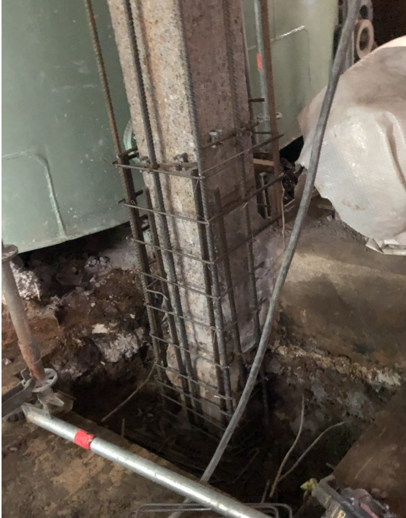
Kuva 5. Raudoitettu manttelointipilari.
