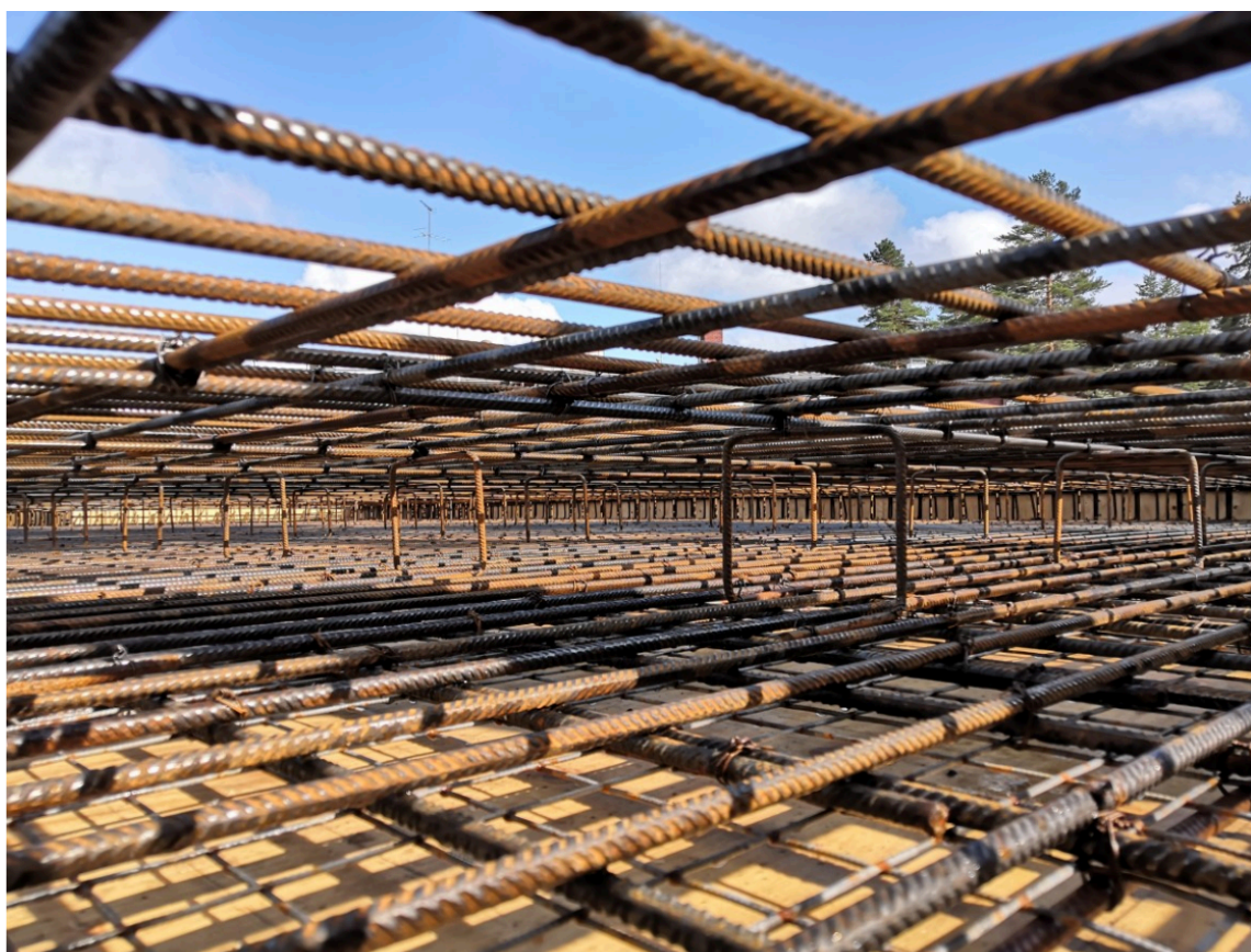
Kuva 21. Väestönsuojan katon raudoitus. (Partti, 2021)
