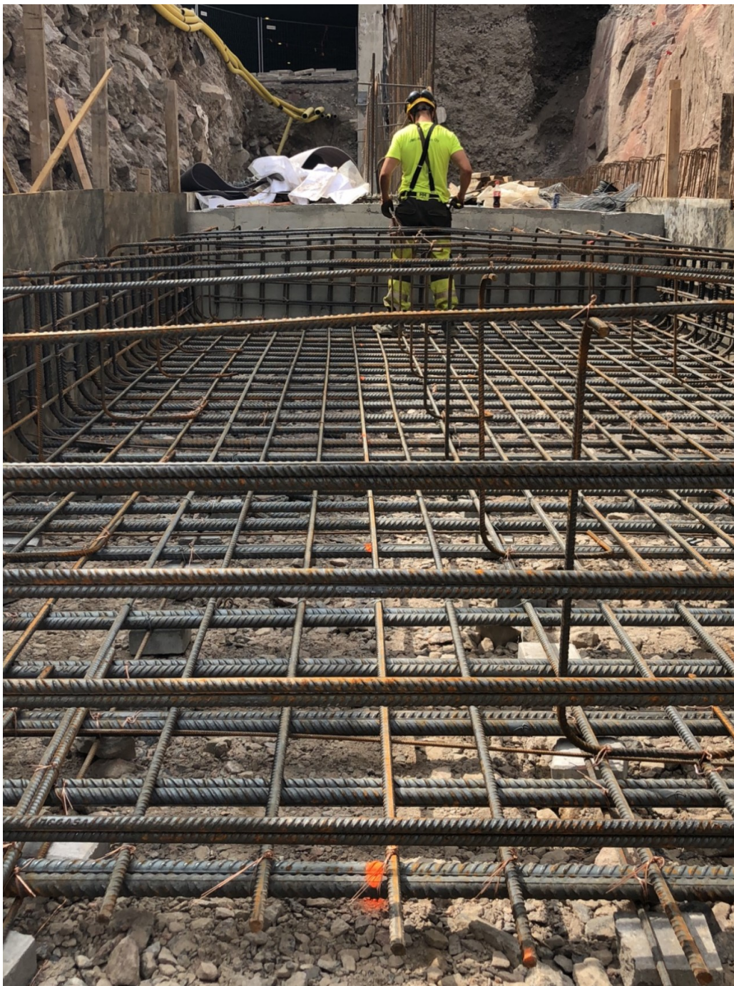
Kuva 9. Kävelysillan anturaraudoituksen tekoa.
