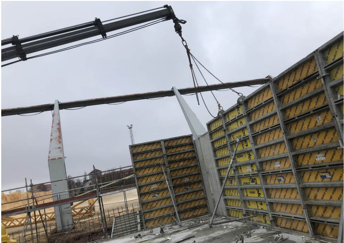
Kuva 6. Doka-seinämuottien asennusta paikalleen työmaalla HIAB-autonostimen avulla.
