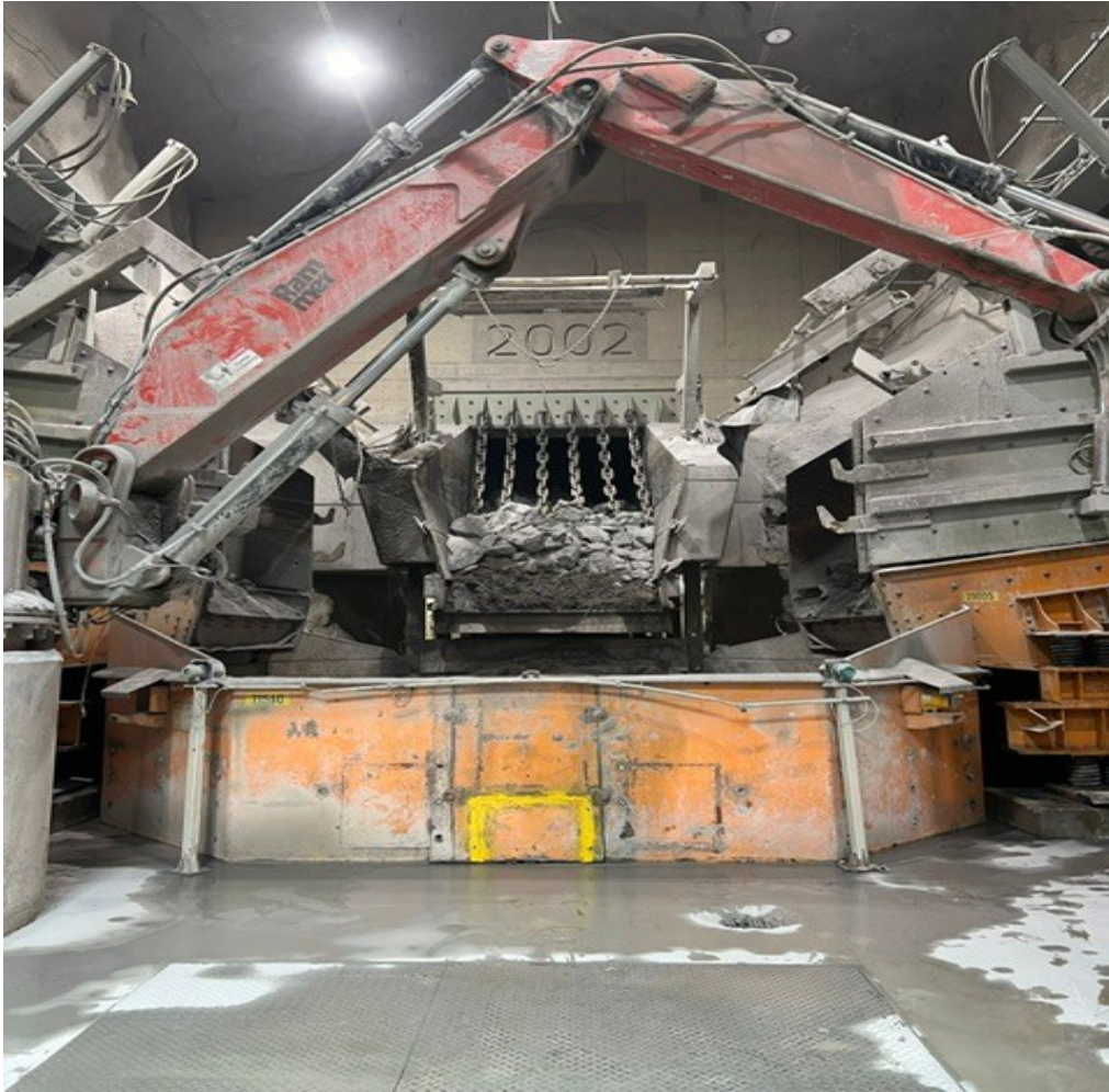
KUVA 9. -550 m tason murskaamo
