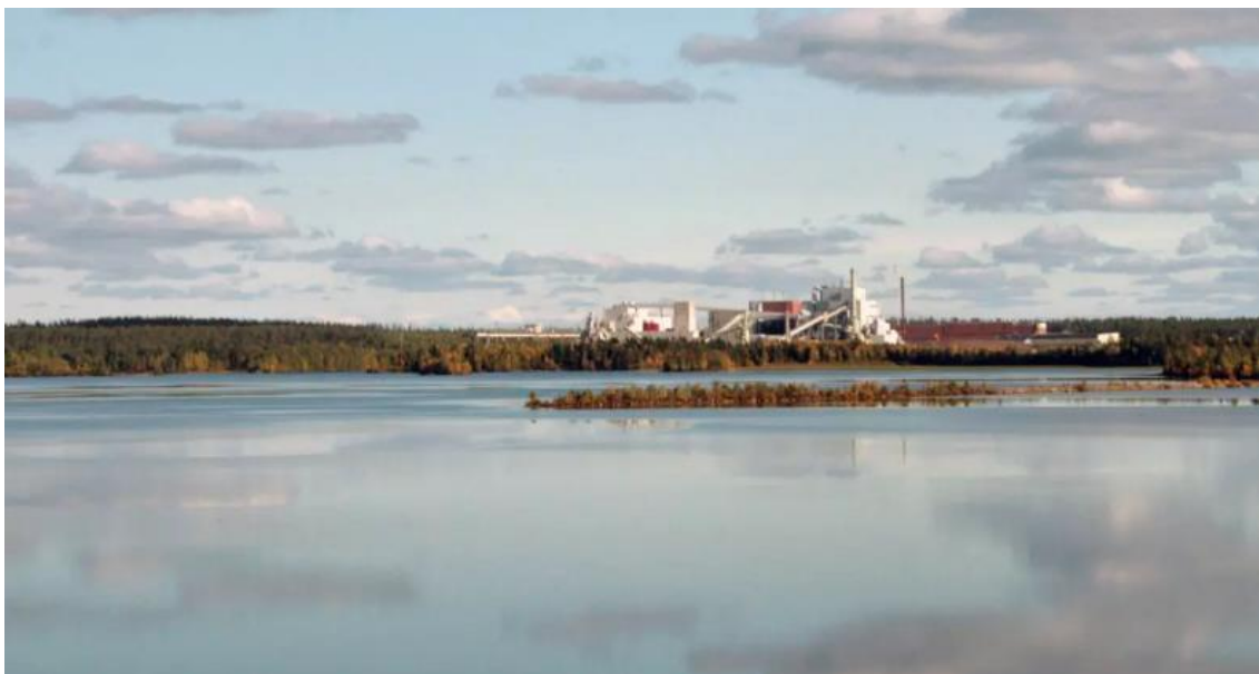
Kuvio 4. Jätevesiallas sijaitsee aivan Kemijärven kupeessa, josta jätevesiallas voi vuotaa suoraan Kemijärveen ja aiheuttaa vahinkoa Kemijärven vesistöön (Toivonen 2017)
