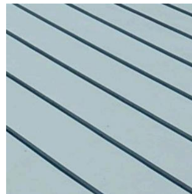
Peltikatto (Kuva: Kattotutka 2020).
