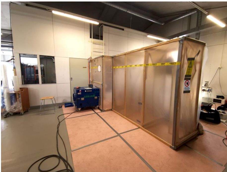
Kuva 5. Valmis osastointi. (Asbestmen, n.d)
