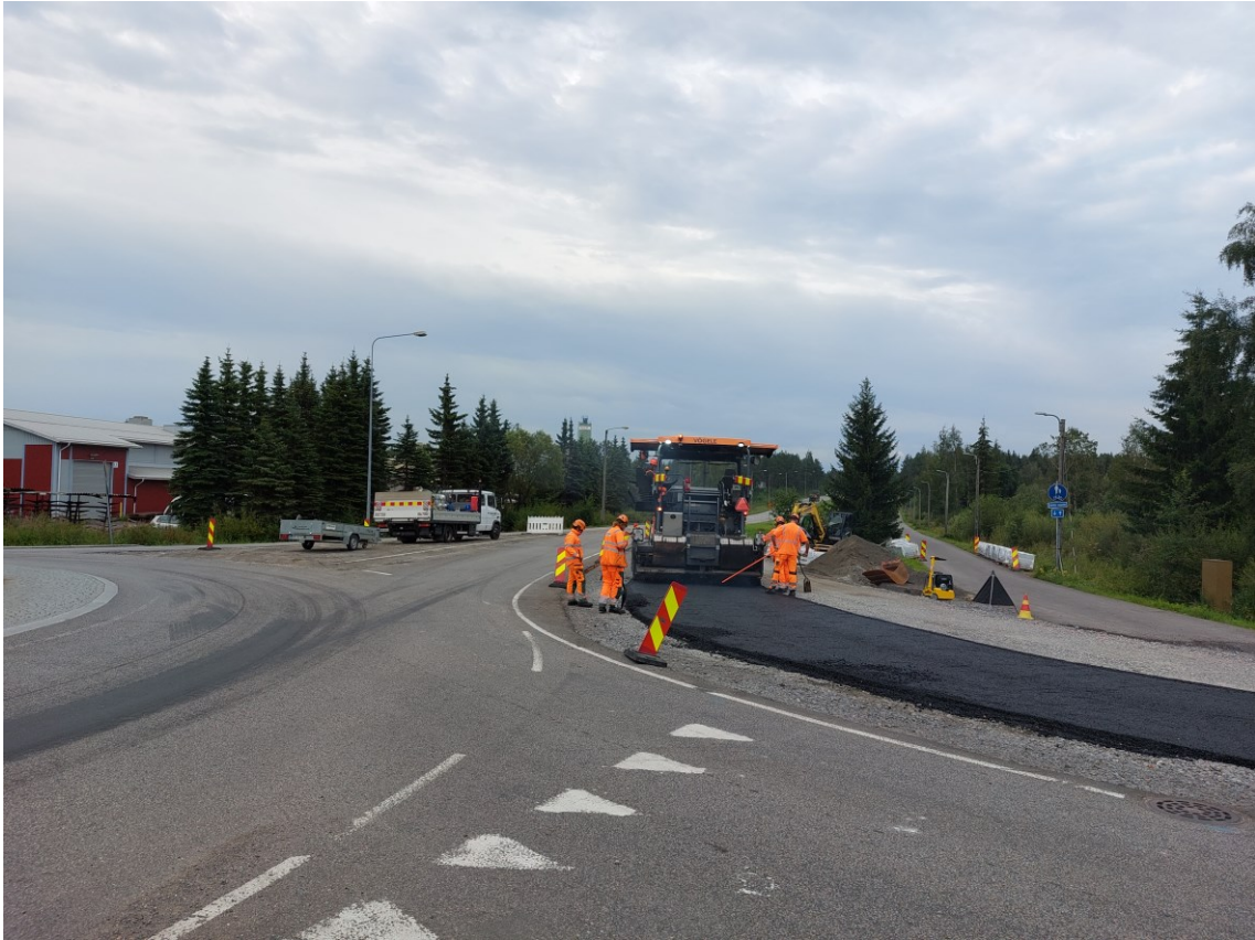
KUVA 12. Levennysrakenteen asfaltointia (Peab Industri Oy 2023)
