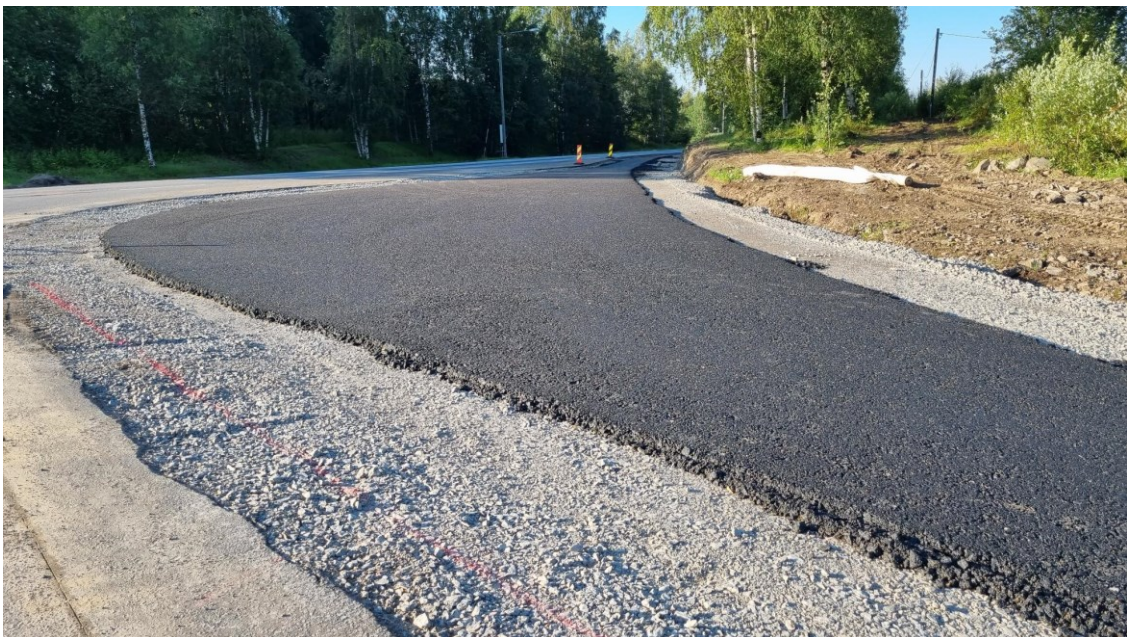
KUVA 13. Levitetty pohjamassa levennysrakenteessa (Peab Industri Oy 2023)
