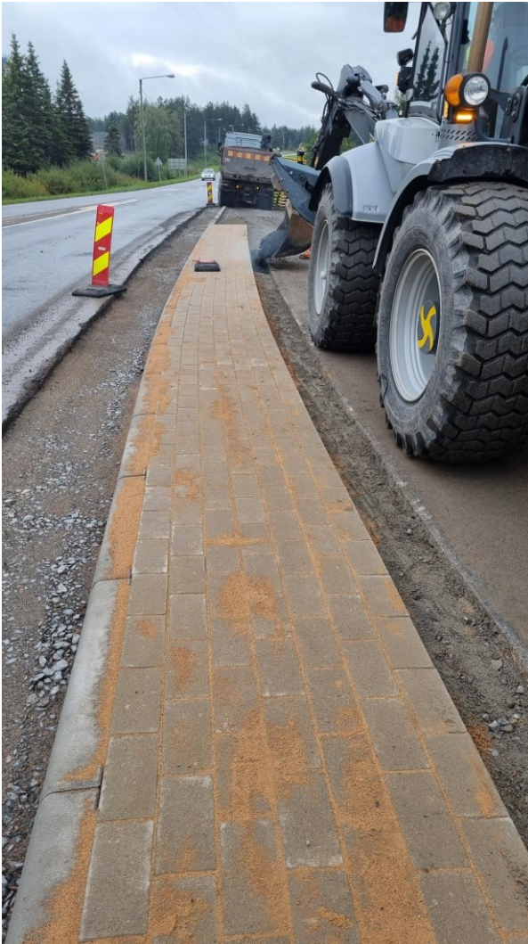
KUVA 11. Betonikiveys risteyksen levennyksessä (Peab Industri Oy 2023)
