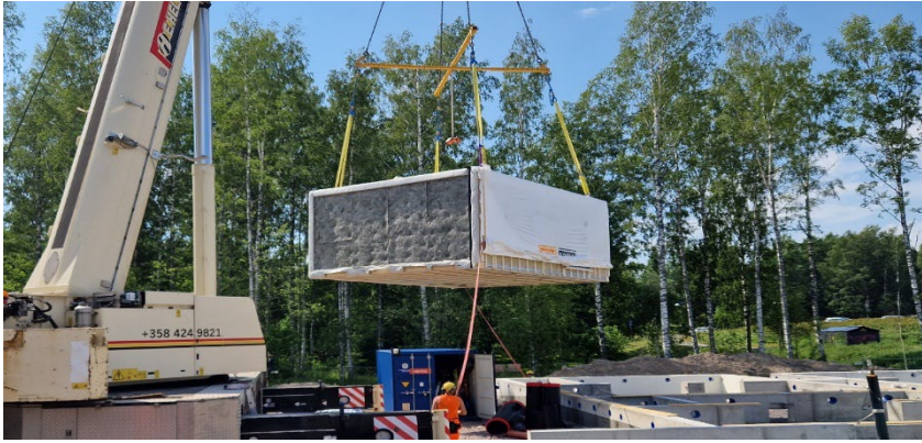
Kuva 10. Tilaelementin nosto (Woodcomp Modules Oy, sisäinen materiaali)
