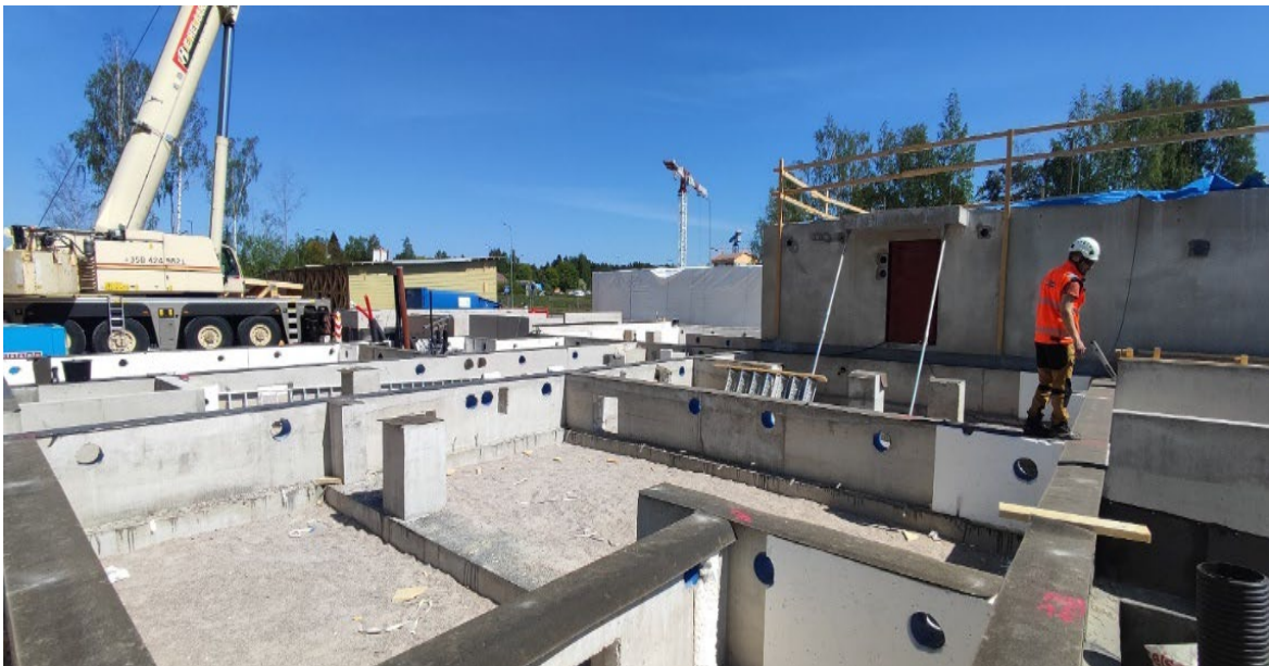
Kuva 9. Työmaan perustukset (Woodcomp Modules Oy, sisäinen materiaali)
