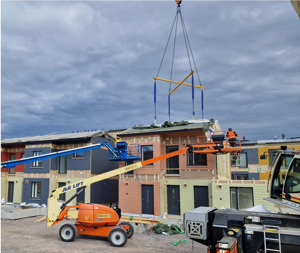
Kuva 8. Asennusta kuukulkijoista (Woodcomp Modules Oy, sisäinen materiaali)
