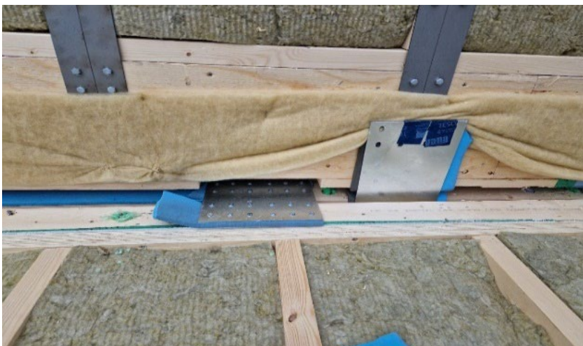
Kuva 16. Elementtisaumojen välisiä kiinnityksiä (Woodcomp Modules Oy, sisäinen materiaali)
