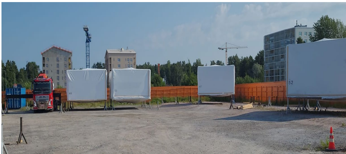
Kuva 5. Tilaelementtejä työmaan välivarastossa (Woodcomp Modules Oy, sisäinen materiaali)
