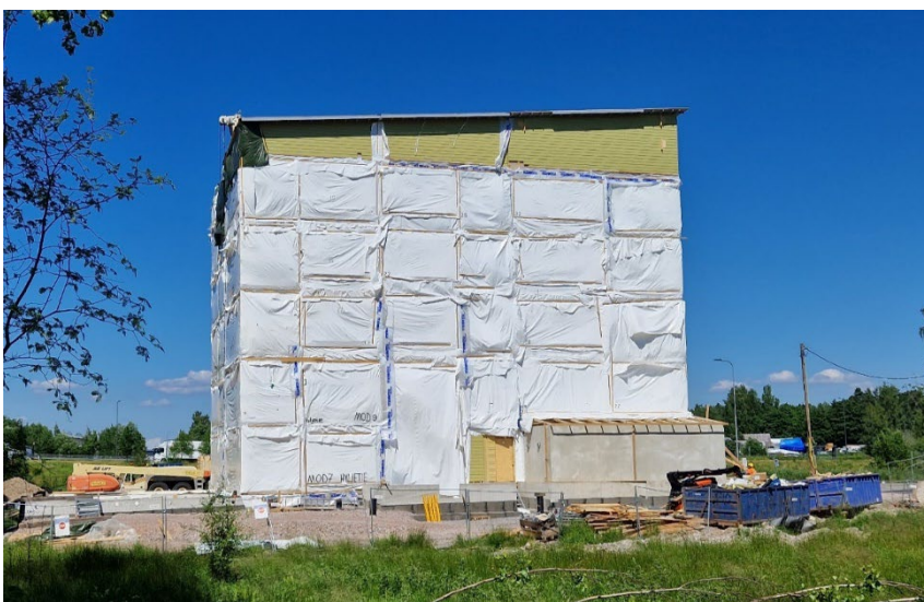
Kuva 2. Puukerrostalo sääsuojassa (Woodcomp Modules Oy, sisäinen materiaali)
