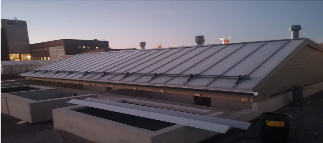
Kuva 13. Katto rakennettu sokkelin päällä (Woodcomp Modules Oy, sisäinen materiaali)
