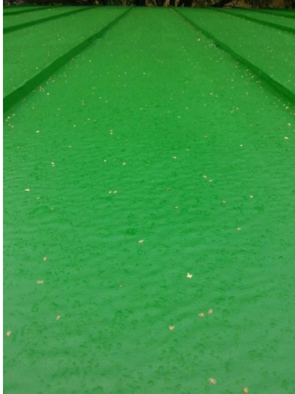
Kuva 3. Konesaumattu peltikatto ja vihreä top coat.
