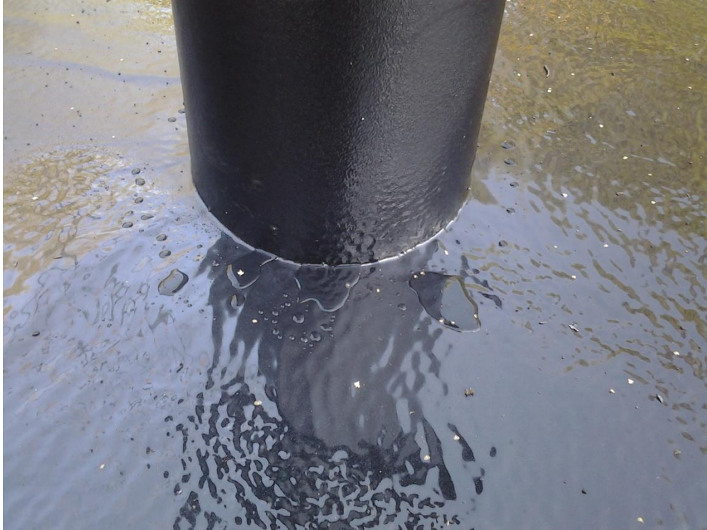
Kuva 2. Läpiviennin vaurion korjaus polyurealla.
