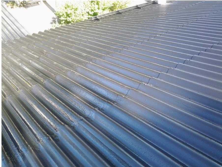
Kuva 10. Pinnoitettu mineriittikatto.
