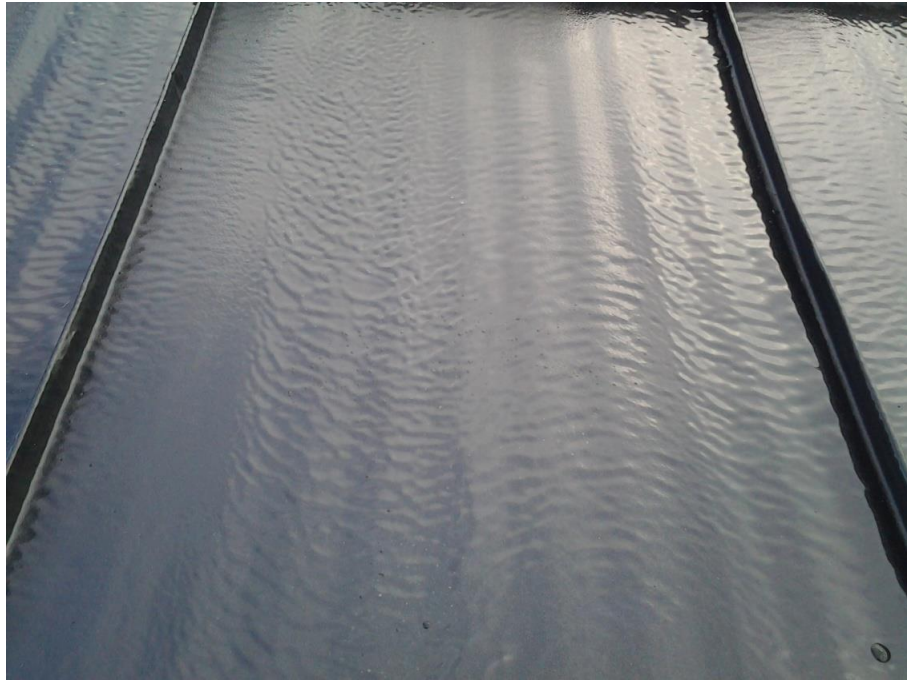
Kuva 11. Pinnoitettu peltikatto.
