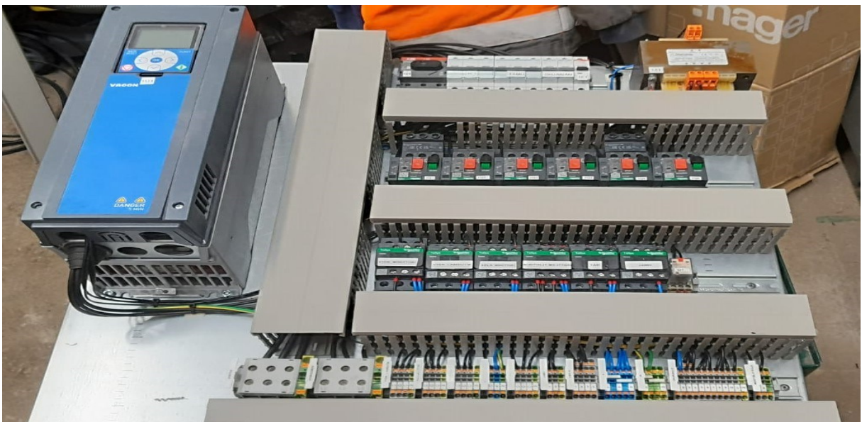
Kuva 18. Uuden keskuksen pohjalevy kalustettuna.
