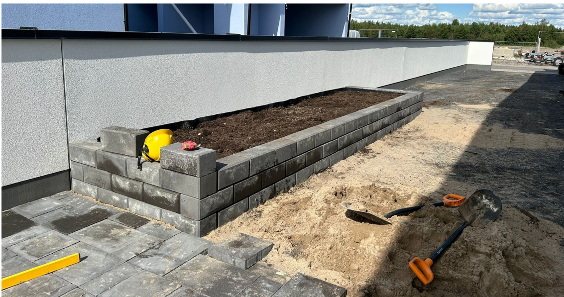
KUVA 11. Muuri, lyhyt istutusallas
