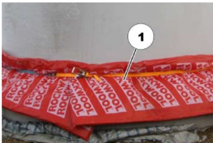
Kuva 10. Juotosbetonointi kylmässä, lämmitys ja eristysmatot käytössä (Vestas, 2017)
