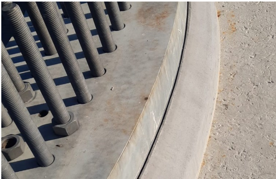
Kuva 3. Valmis juotos paineentasauslevyn ja perustuksen välissä (Paananen, 2023)
