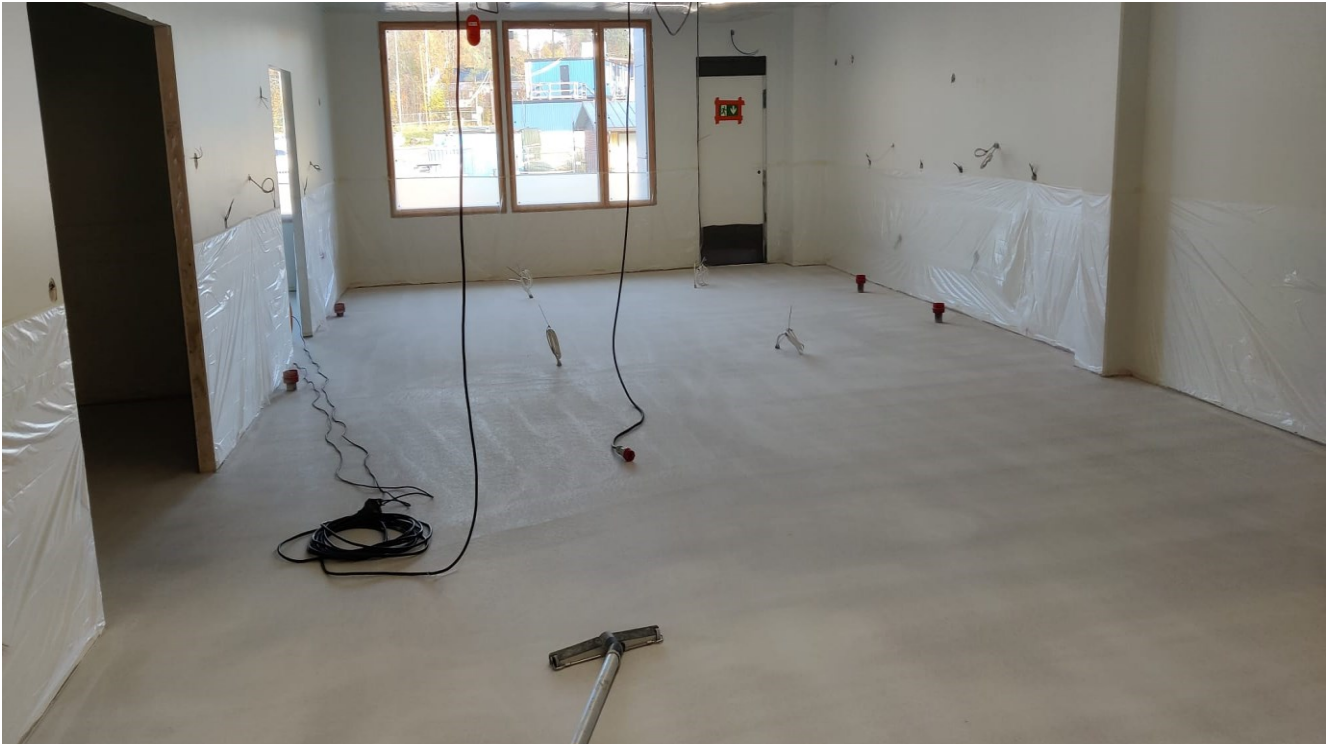
Kuva 3. Hiontapölyn poisto imuroimalla (Lahti, i.a.).
