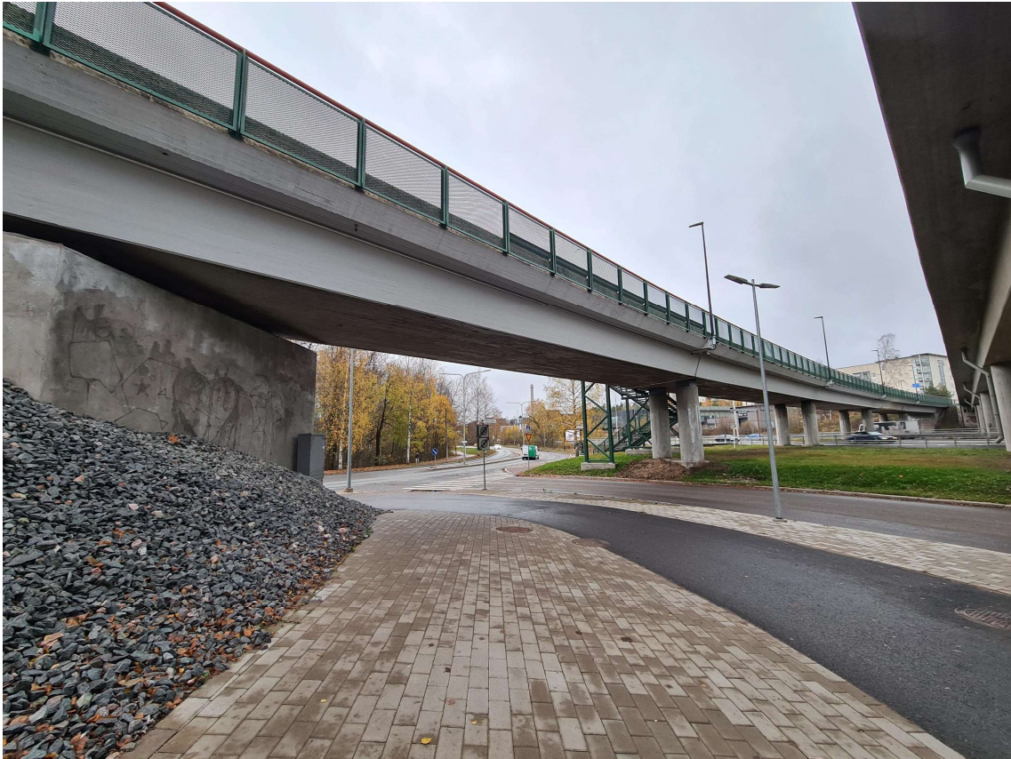
KUVA 17. Herttoniemen silta Lahdentien yli (5)
