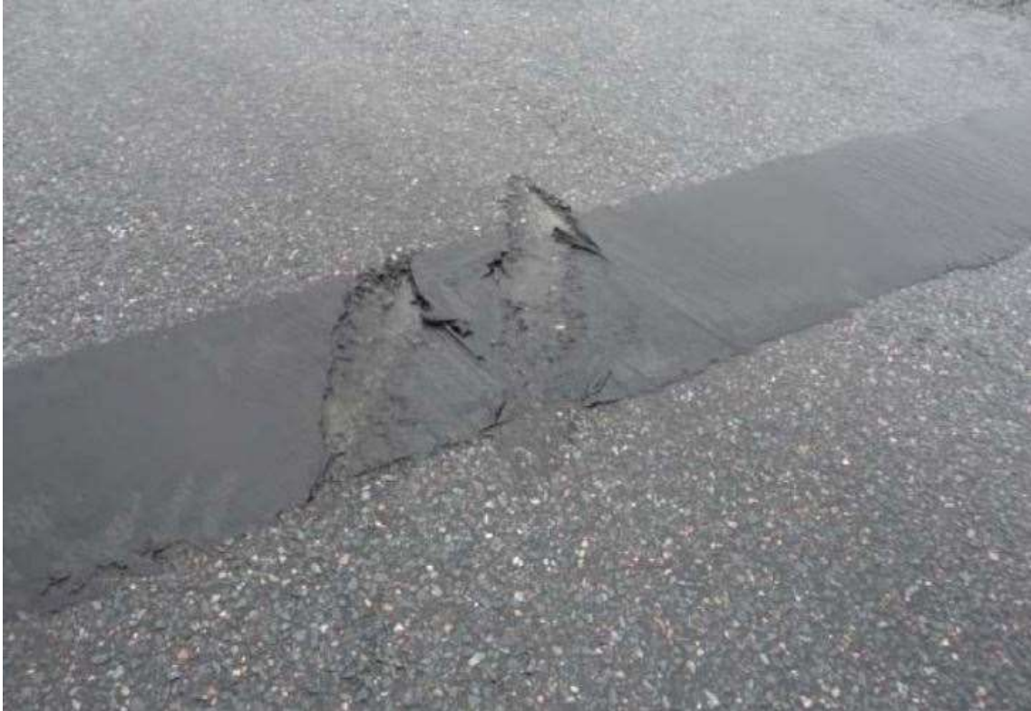
KUVA 8. Höyläysjälki massaliikuntasaumassa (7)
