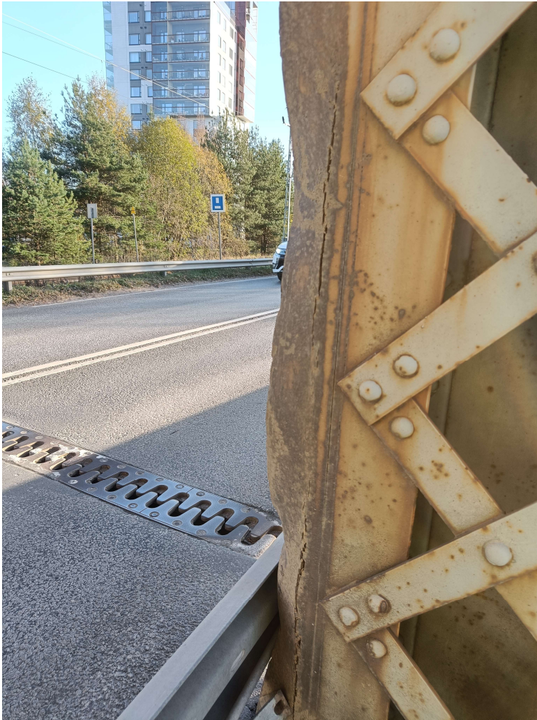
KUVA 7. Sormiliikuntasaumalaite, Vanha rautatiesilta (4)
