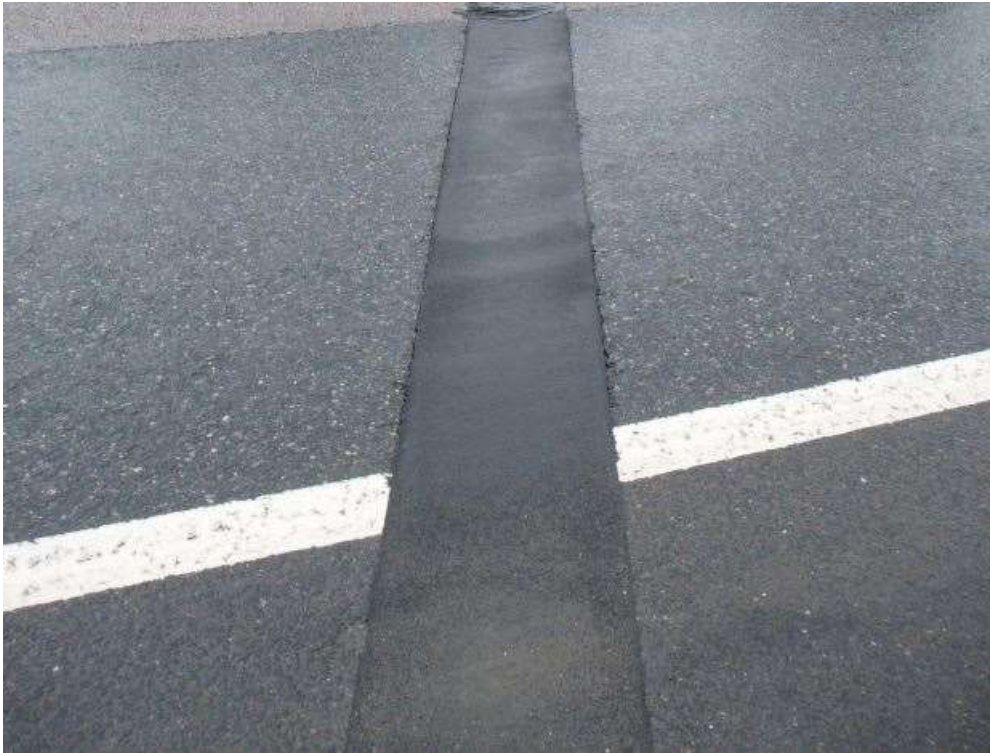
KUVA 2. Bitumiton polymeerimassaliikuntasauama (4)
