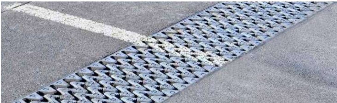
KUVA 6. Erillisillä sormilevyillä varustettu Mageban monikuminen liikuntasaumalaite (6)
