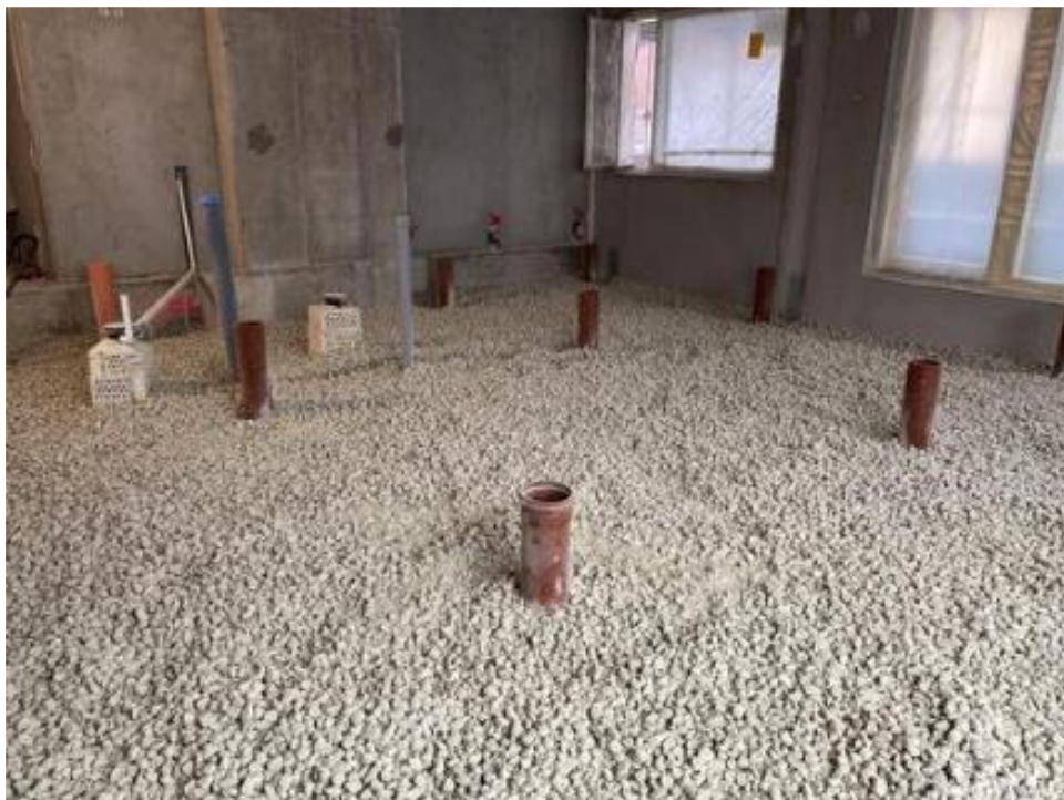
KUVA 21. Vaahtolasi täyttö (Hartela 2024)
