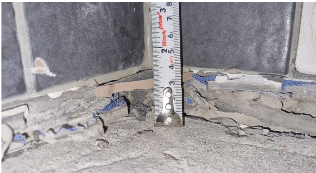
KUVA 10. Purettu lattiarakenne saunassa, sama kulma kuin edellä (Hartelan raportti 2021)
