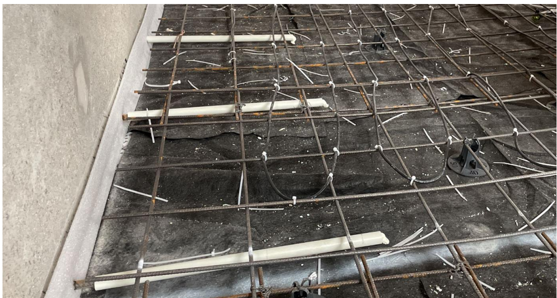
KUVA 19. Työmaa aikainen valokuva tartunnoista (Hartela 2023)
