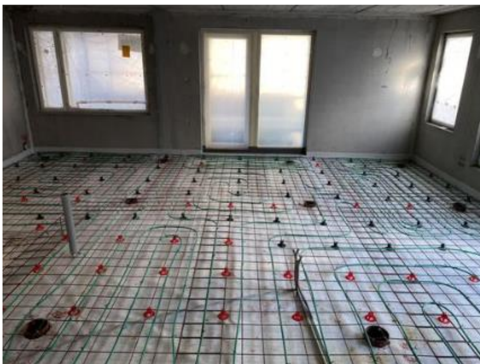
KUVA 22. Laatan rauditus työt tehty. Raudituksen alla pilareiksi valettavien putkien suut. (Hartela 2024)
