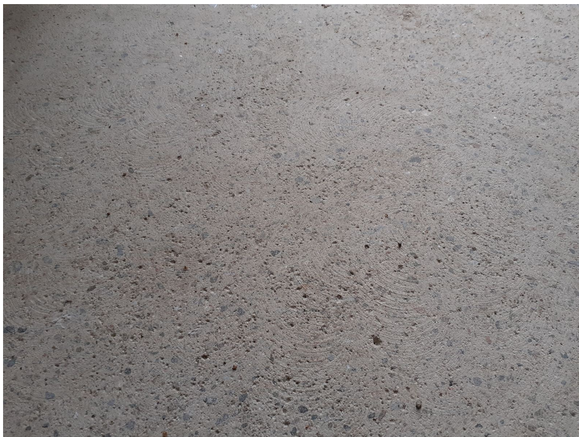
Kuva 5. Huolellisesti hiottu betonilattiapinta, jonka runkoaines on selvästi nähtävissä.
