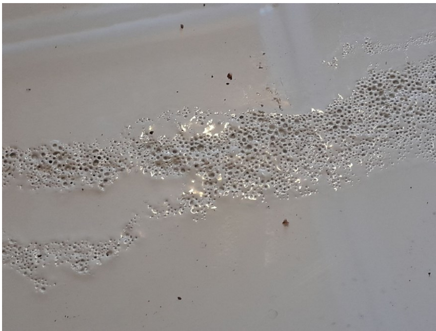
Kuva 10. Kovettumisvaiheessaan nestemäiselle vedelle altistunut polyuretaanilattiapinnoite. Pinnoitteen rakenteeseen on muodostunut merkittäviä huokosia ja epätasaisuuksia.
