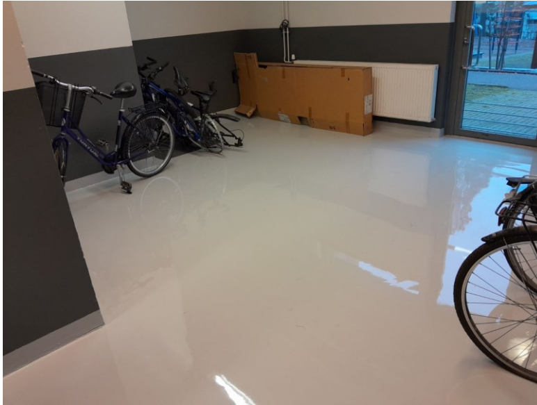
Kuva 3. Lattiapinnoituksen tavoiteltu työnjälki.
