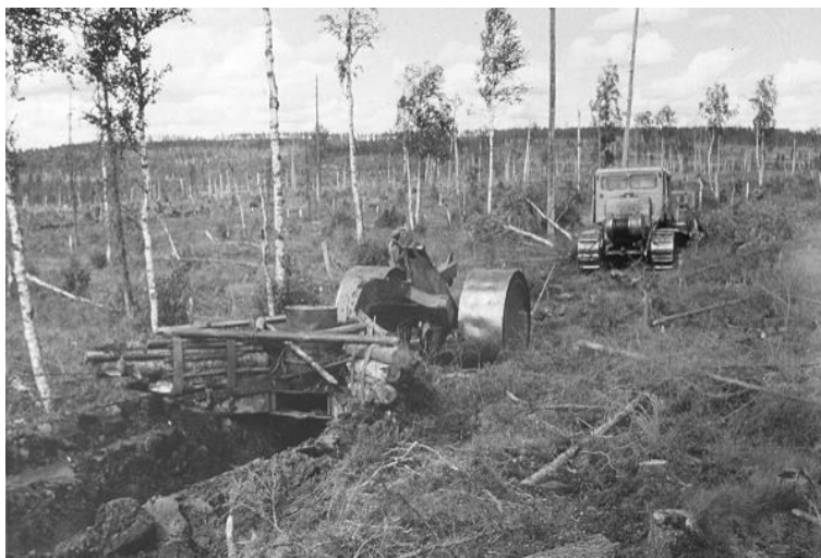
Kuva 24. Suon metsäojittamista metsäoja-auraa vinssaamalla 1950-luvulla (Mansner 1959)
