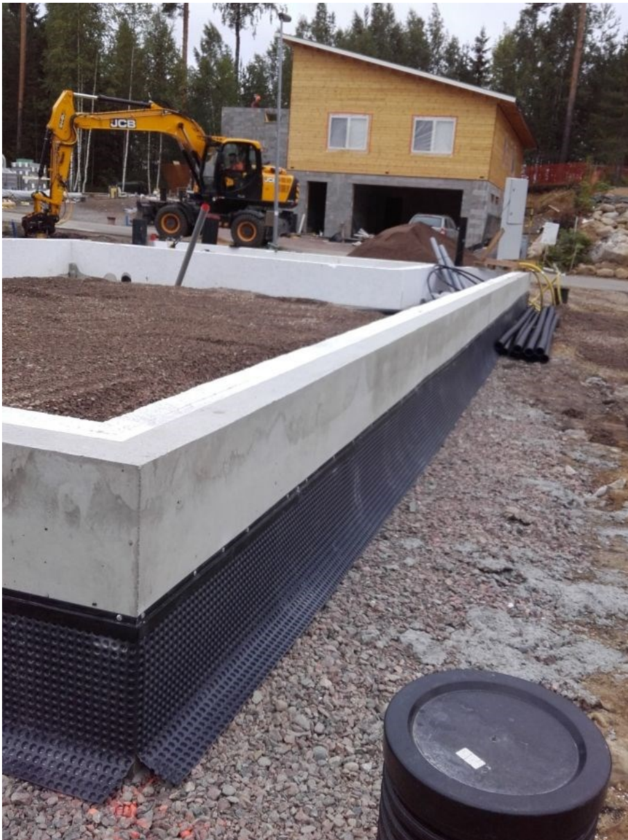
KUVA 4. Patolevy valmiissa sokkelissa (13)
