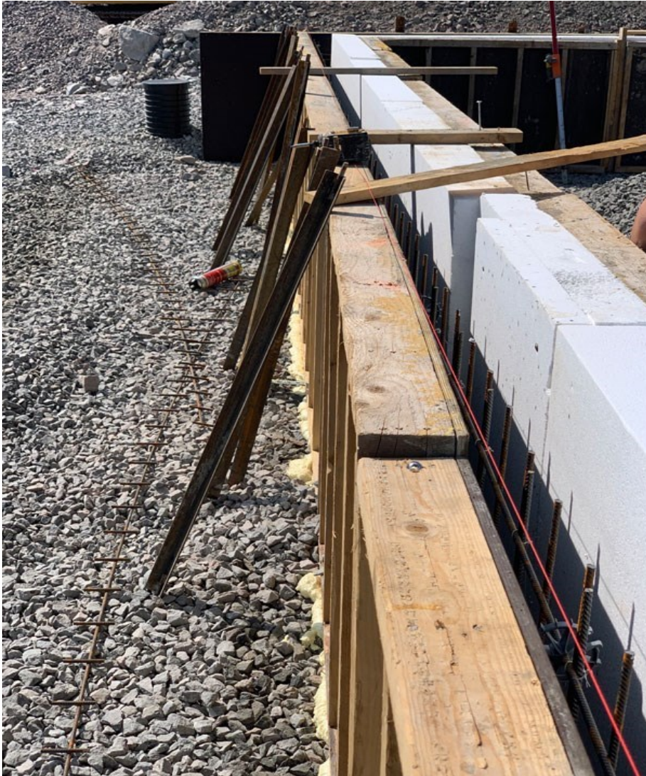
KUVA 3. Lämpöeristeet sokkelimuotissa (11)
