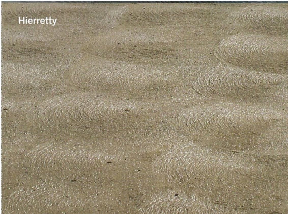
KUVA 4. Konehierretty pinta (By 40 Betonirakenteiden pinnat / luokitusohjeet 2021, 121)
