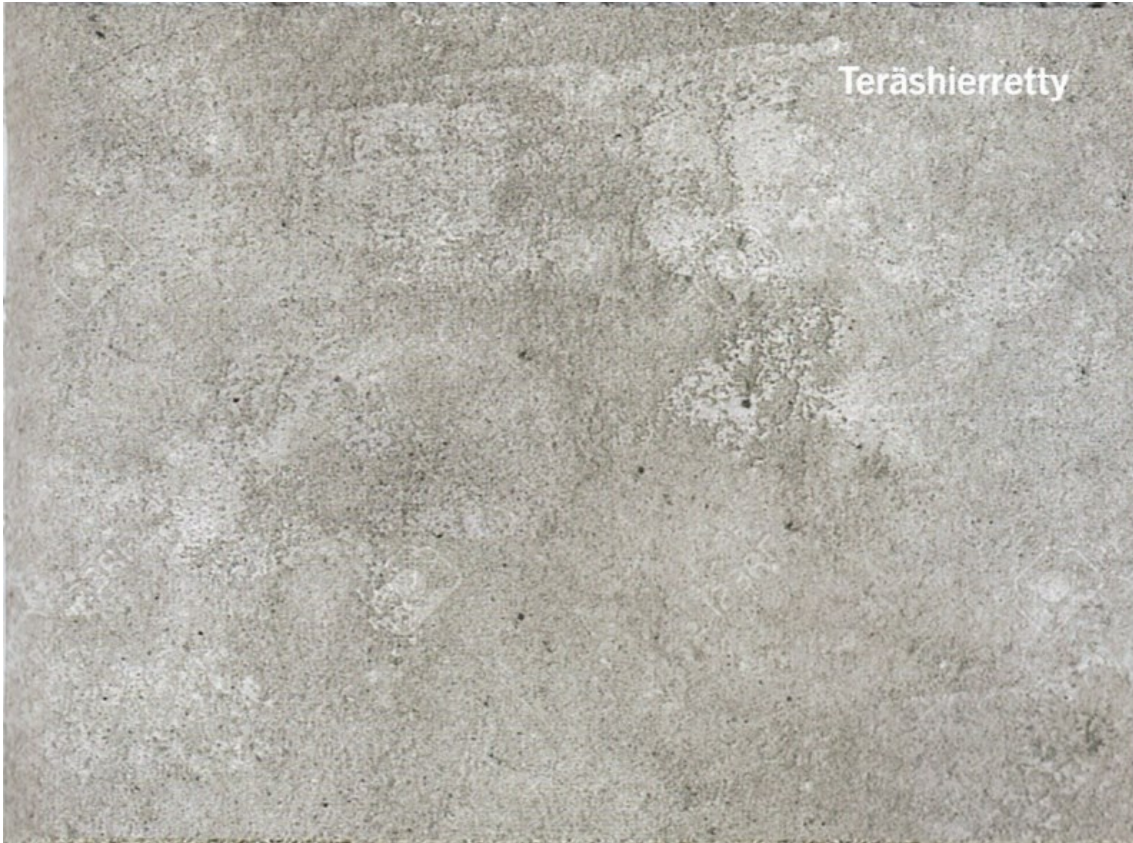
KUVA 3. Teräshierretty pinta (By 40 Betonirakenteiden pinnat / luokitusohjeet 2021, 121)
