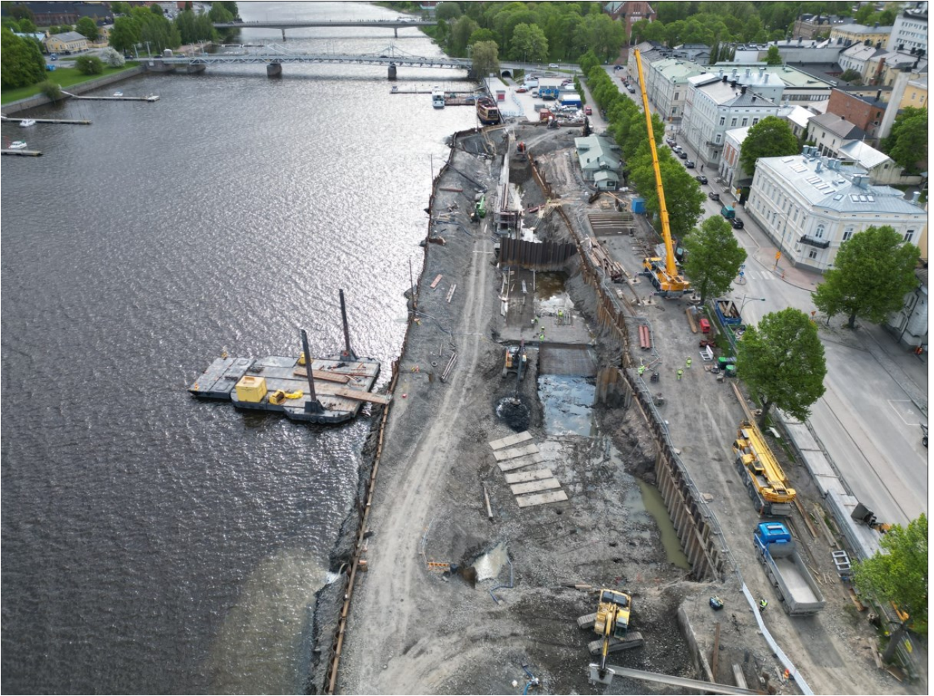
Kuva 5. Ponttiseinä työmaa (Tuomenpuro, 2023).
