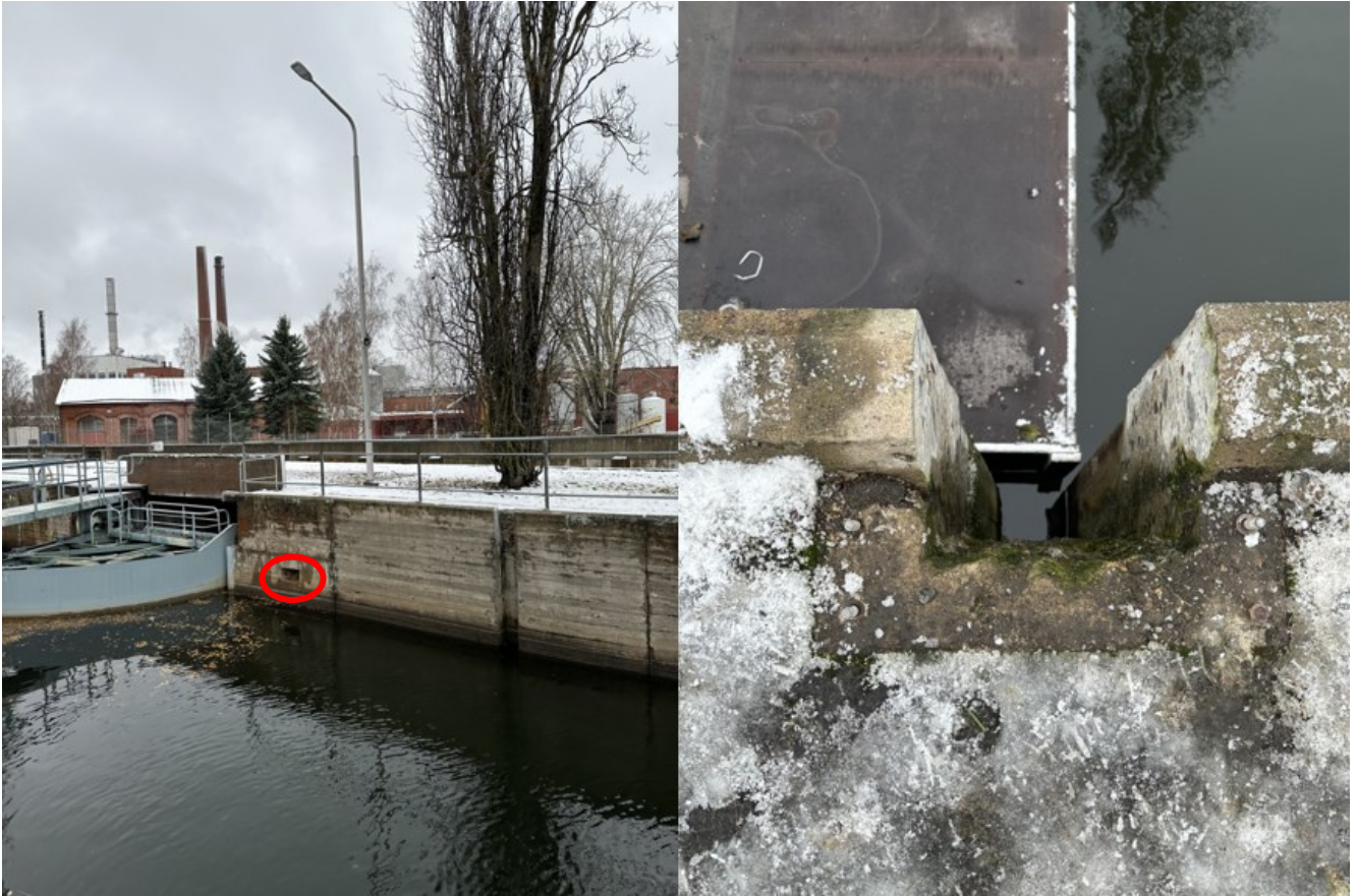
Kuva 8. Valkeakosken kanavan yläportti (Demir, 2023).
