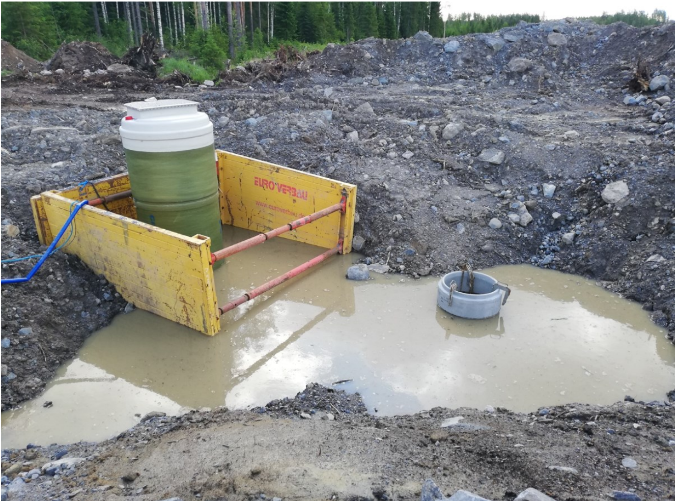
Kuva 1. Kaivantotuki (Partinen, 2019).
