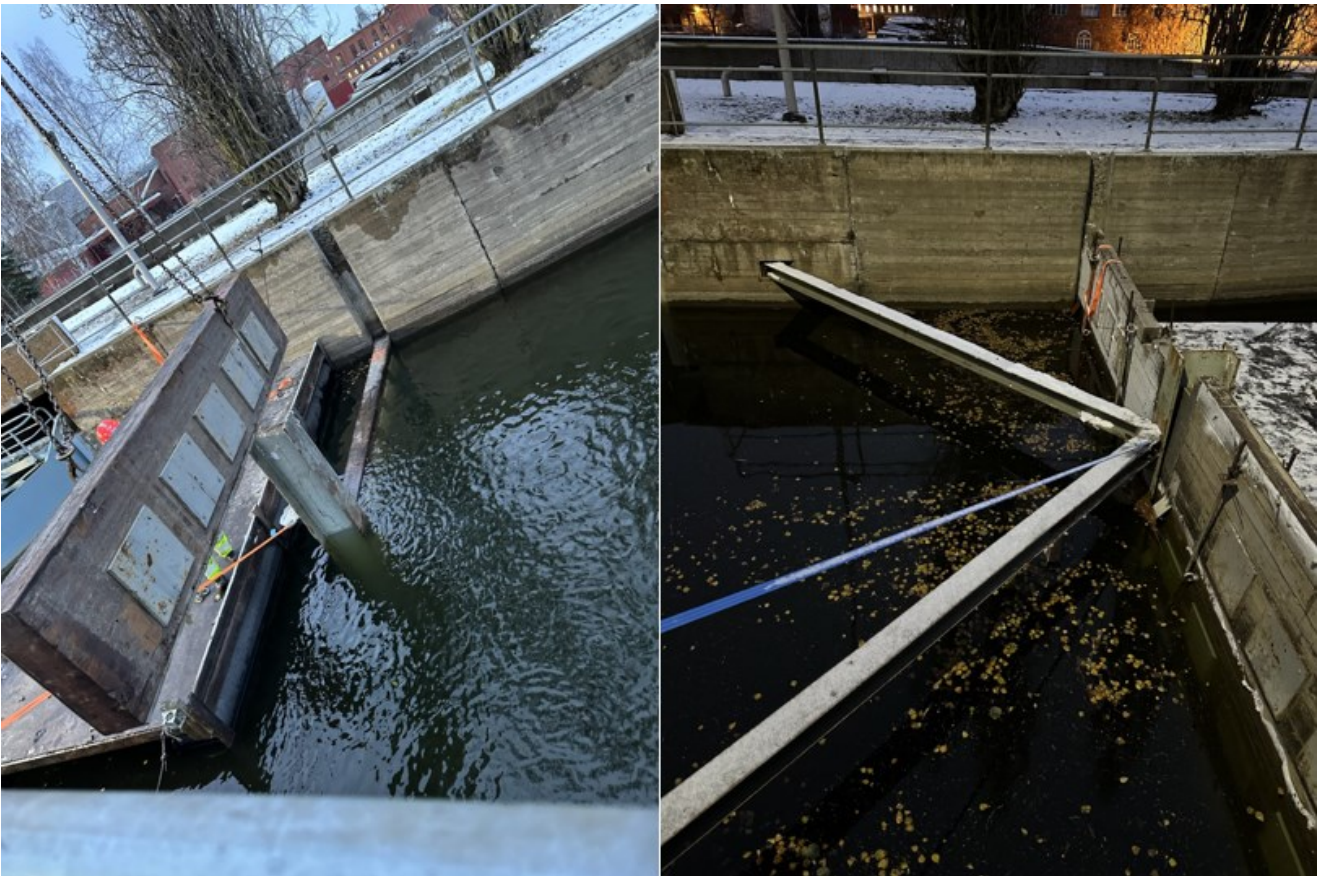
Kuva 11. Settipadon vinotuet (Demir, 2023).
