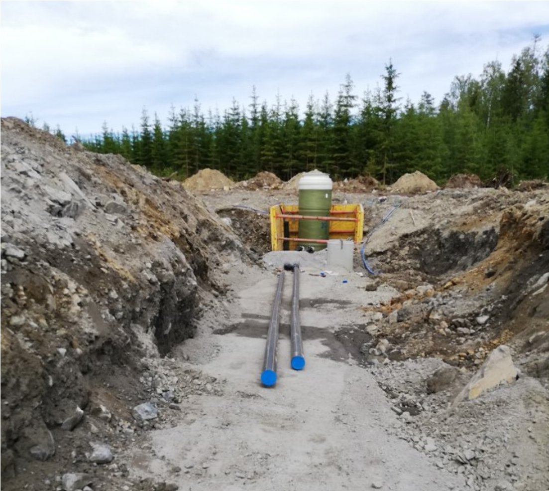
Kuva 2. Kaivantotuki (Partinen, 2019).
