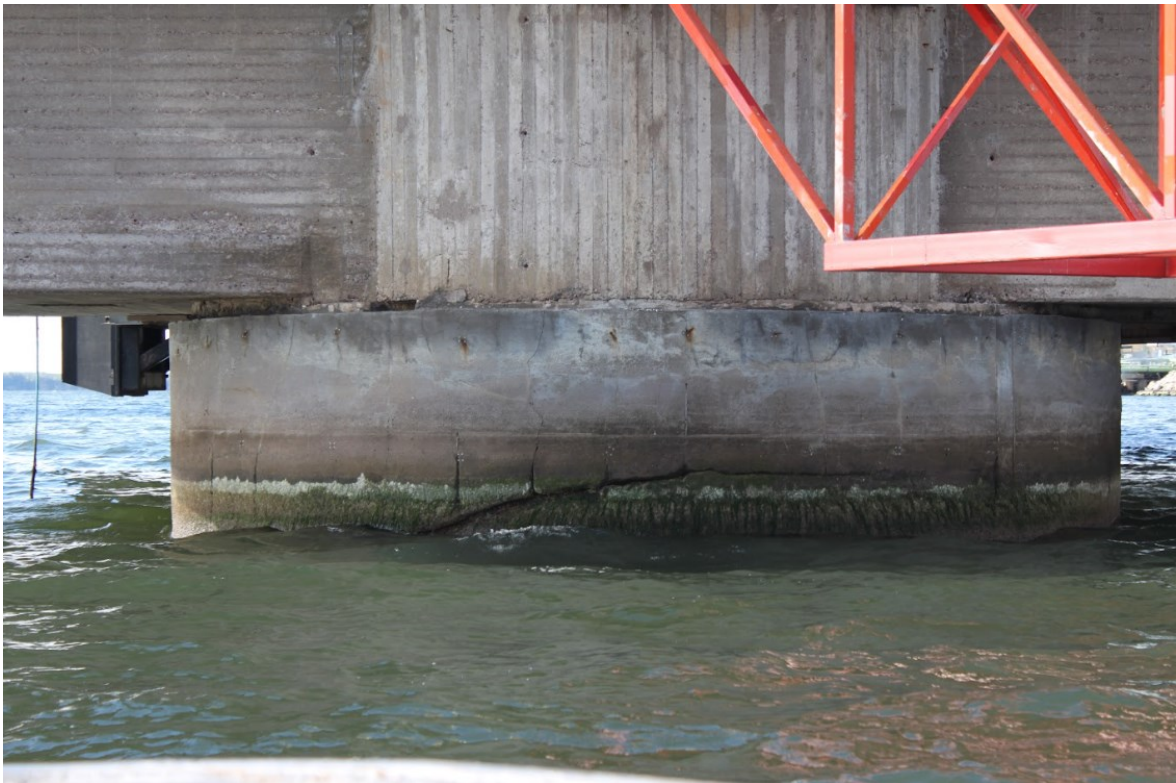
Kuva 6 Haljennut tihtaali. (Nestein sisäinen arkisto, 2023)
