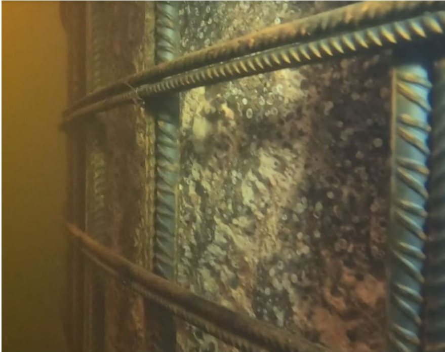
Kuva 3 Raudoitus veden pinnan alla. (Nesteen sisäinen arkisto, 2023)
