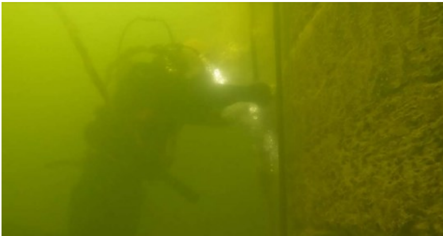
Kuva 7 Sukeltaja poraamassa tartuntoja. (Nesteen sisäinen arkisto, 2023)
