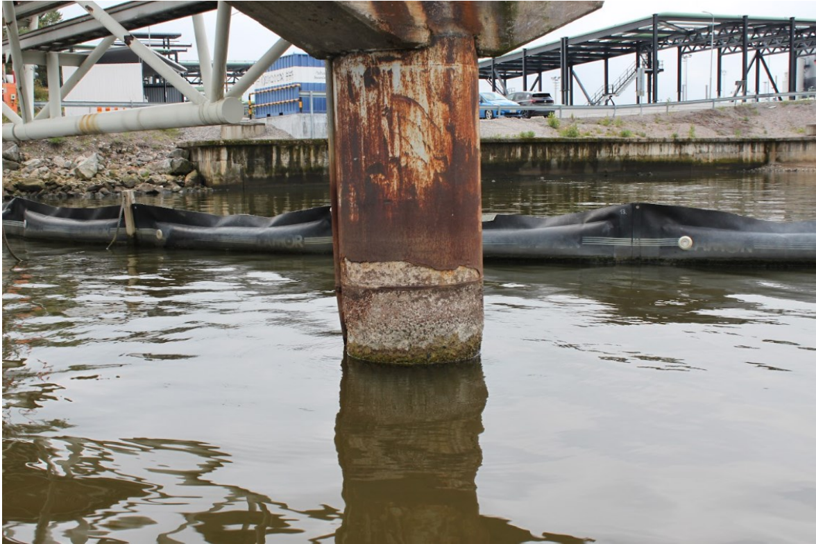
Kuva 8 Korjauksen tarpeessa oleva tihtaali. (Nesteen sisäinen arkisto, 2023)
