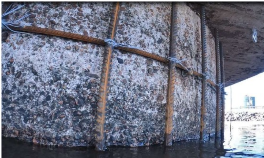
Kuva 2 Raudoitus veden pinnan yläpuolella. (Nesteen sisäinen arkisto, 2023)
