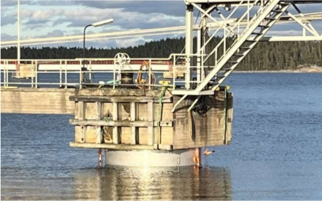
Kuva 5 Kuvassa esiintyvän tihtaalin korjauksessa yhdistettiin erilaisia menetelmiä. (Nesteen sisäinen arkisto, 2023)
