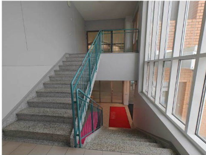
Kuva 50. Portaiden rytmi on tasainen. Portaissa on ulkoneva etureuna, jollainen ei ole suositeltava portaissa.
