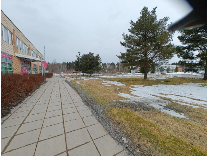
Kuva 8. Kulkuväylä auditorion päädyssä sijaitsevan parkkipaikan suunnasta kohti pääovea.
