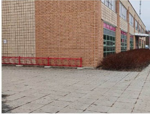
Kuva 8. Kulkuväylän reunalla oleva polkupyöräparkki erottuu värikontrastina seinäpinnasta.
