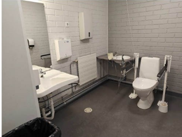
Kuva 56. Wc-tilassa on käsisuihku, joka on pytyllä istuessa selän takana ja saattaa olla siksi vaikea saavuttaa.
