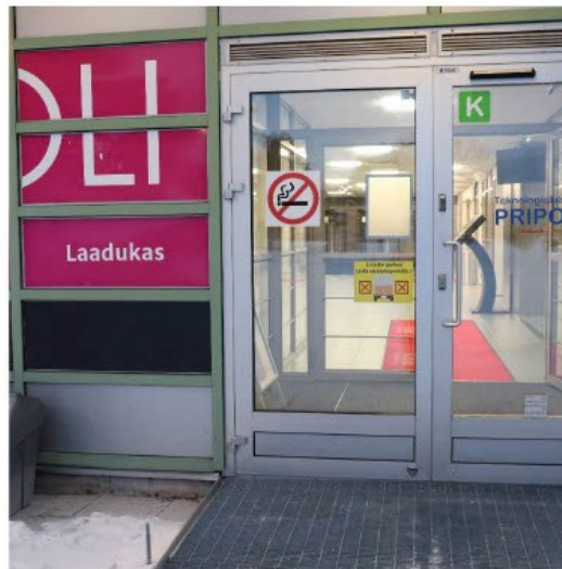
Kuva 11. Oven kahva on lähes samanvärisin ja samaa materiaalia oven pielen kanssa. Teräsristikkoluiska erottuu hyvin vaaleammasta laatoituksesta.
