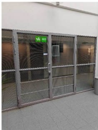
Kuva 51. Tapahtuma-aulasta toiseen kerroksen tulevien portaiden yläpäässä on käytävään johtava ovi.
