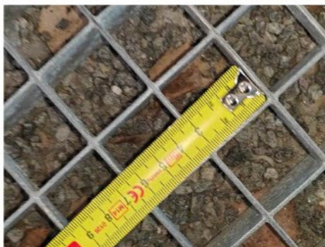
Kuva 61. Oven edessä olevan luiska ritilän raon koko on suositeltua suurempi.
