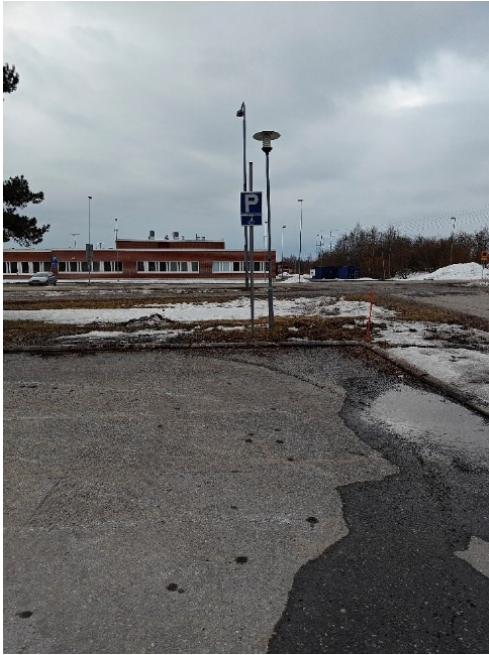
Kuva 7. Esteettömällä autopaikalla on liikennemerkkit, mutta maalaukset puuttuvat ruudusta.
