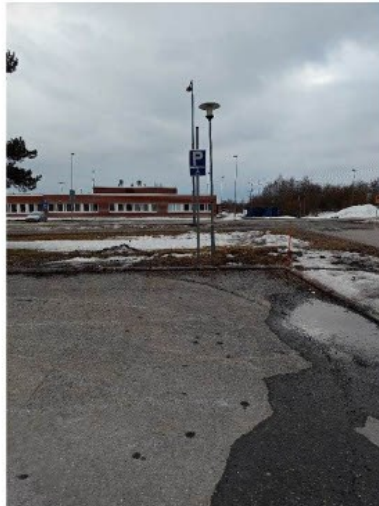
Kuva 4. Kuvassa olevassa ruudussa ei ole maalattua ISA-pyörätuoitunnusta eikä ruudun maalauksia ole näkyvissä.
