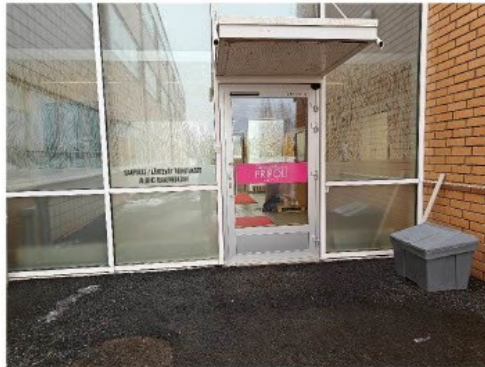
Kuva 54. Molempien ovien yläpuolella pieni katos sekä ovessa ympäröivästä lasiseinästä värikköinä erottuva teippaus.
