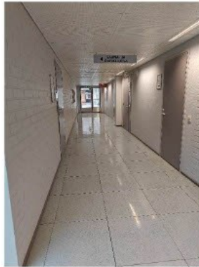
Kuva 19. K-rakennuksen toisen kerroksen käytävän katossa roikkuvat opasteet ovat hieman liian alhaalla.
