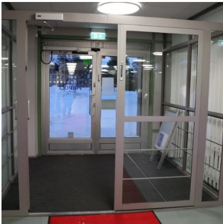
Kuva 10. K-rakennuksen pääsisäänkäynnin tuulikaappi.
