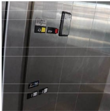
Kuva 22. Hissin ohjauspaneeli. Painikkeet kahdella eri korkeudella.
