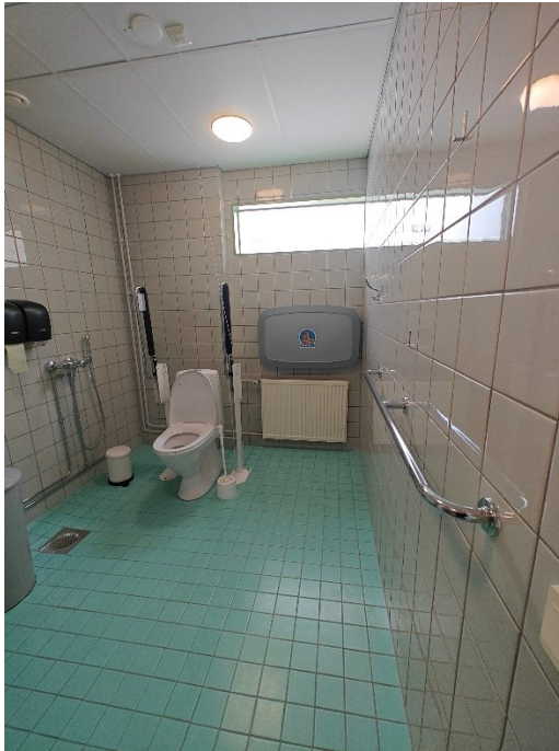
Kuva 12. K-rakennuksen esteetön wc-tila.
