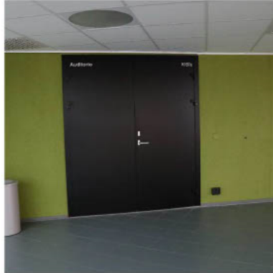
Kuva 33. Auditorion ovesta valkoinen teksti erottuu tummuuskontrastina tummasta ovesta. Ovi erottuu myös vihreästä seinästä väri- ja tummuuskontrastina.
