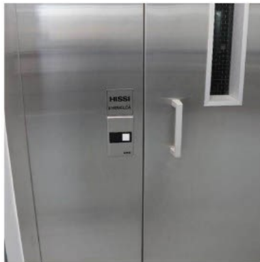
Kuva 20. Hissin oven ulkopuolella olevat painikkeet. Valo syttyy nappia painaessa. Painikkeiden sijoituskorkeus 960 mm on suositusten mukainen.
