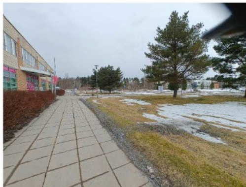
Kuva 7. Kuva kulkuväylästä. Valaisimet on asennettu nurmialueelle eivätkä aiheuta törmäämisvaraa kulkuväylällä.
