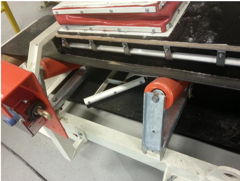
Kuva 2 Kuljetin ilman suojausta
