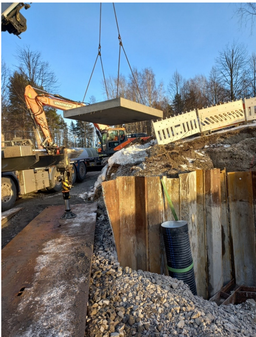
Kuva 9. Pohjalaatan asennus (Kuva: Tommi Mälkiäinen)
