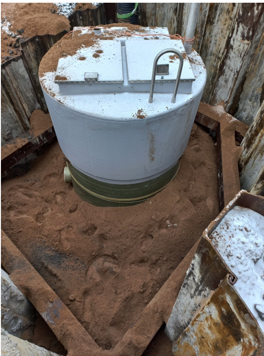
Kuva 11. Täyttö (Kuva: Tommi Mälkiäinen)
