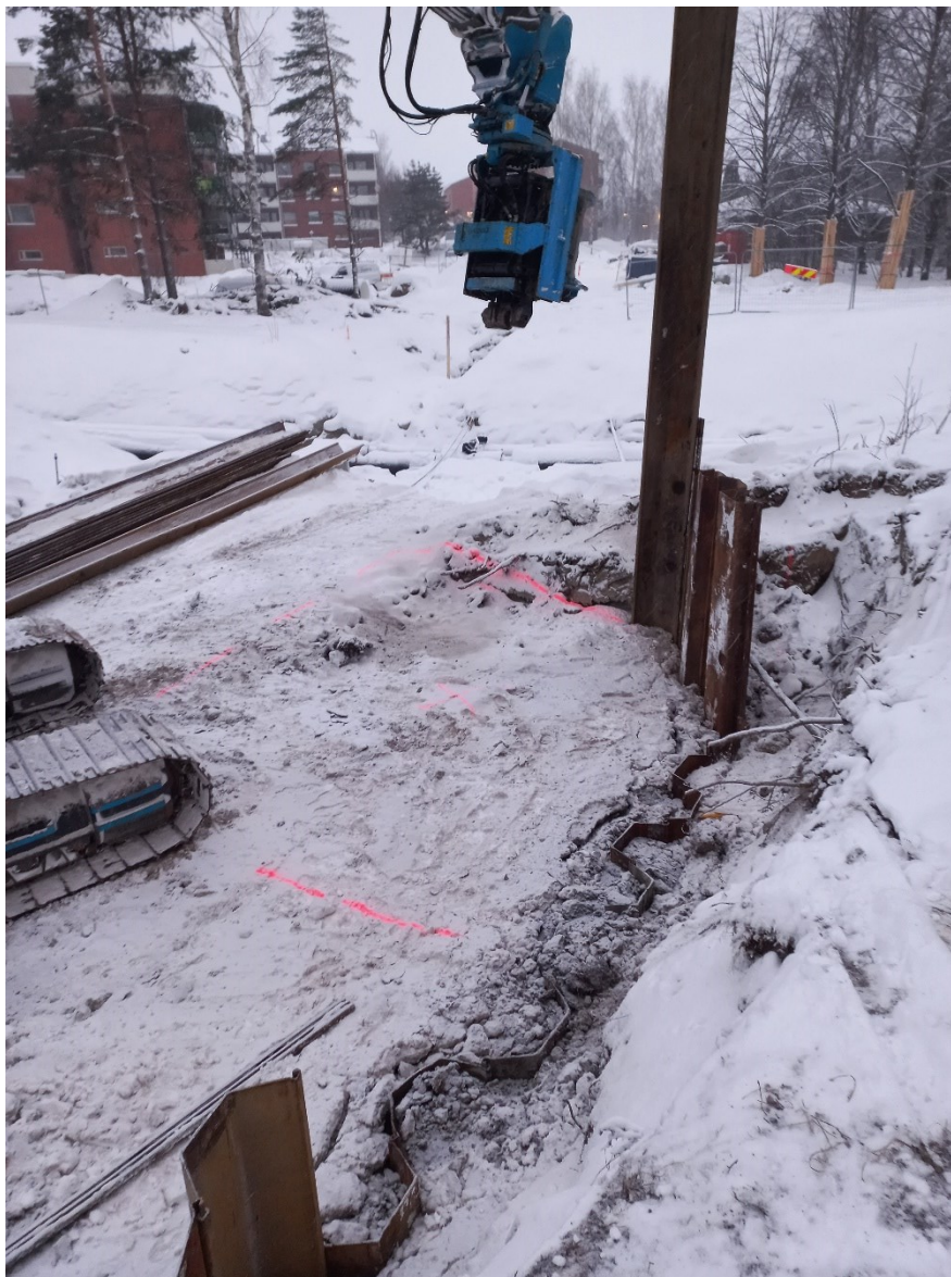
Kuva 8. Teräsponttiseinän asennus (Kuva: Tommi Mälkiäinen)
