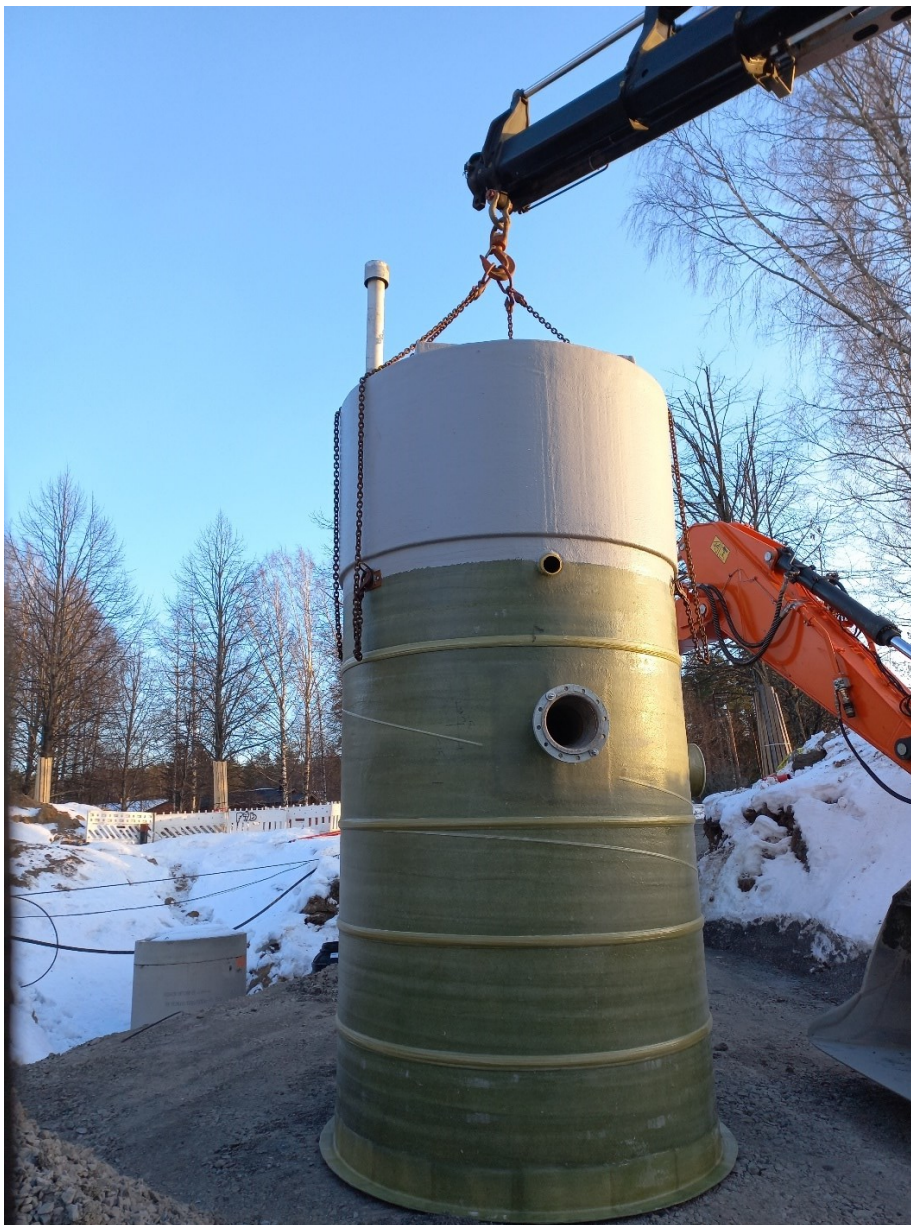
Kuva 10. Pumppaamon nostotyö (Kuva: Tommi Mälkiäinen)
