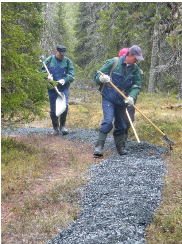
KUVIO 13. Talvella levitetty sorakerros tasoitetaan keväällä (Metsähallitus)
