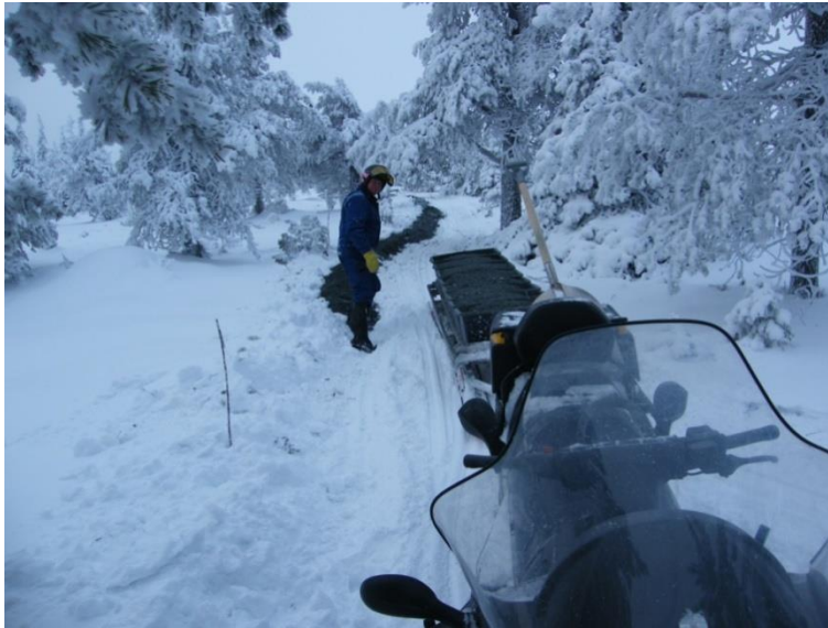
KUVIO 12. Merkitylle uralle levitetään sorakerros talvella (Metsähallitus)
