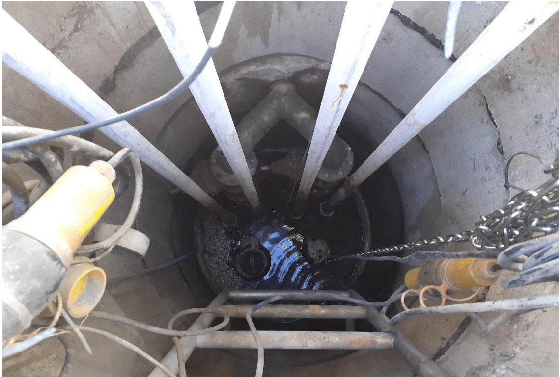
Kuva 12: Betonisäiliö. Kuvassa näkyy betonirenkaiden liitokset.
