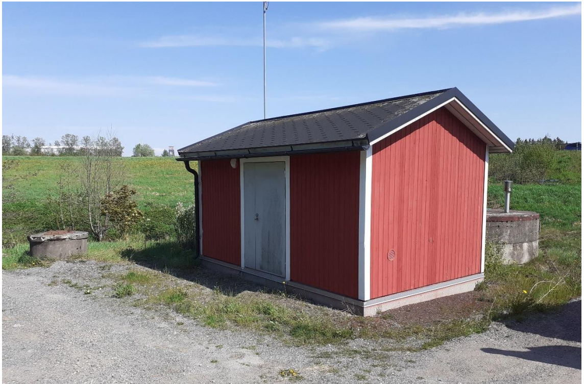
Kuva 10: Mökkipumppaamon huoltorakennus, jonka takana näkyy imusäiliö.
