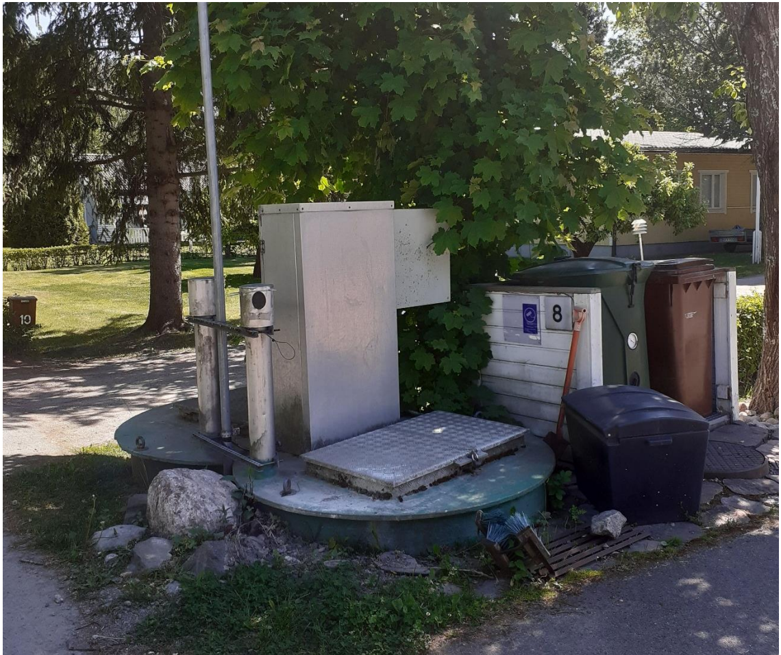
Kuva 16: Joskus pumppaamo saattaa sijaita pihapiirin välittömässä läheisyydessä. Tällöin pumppaamon ulkopuolisten rakenteiden turvallisuus on ehdottomasti taattava.
